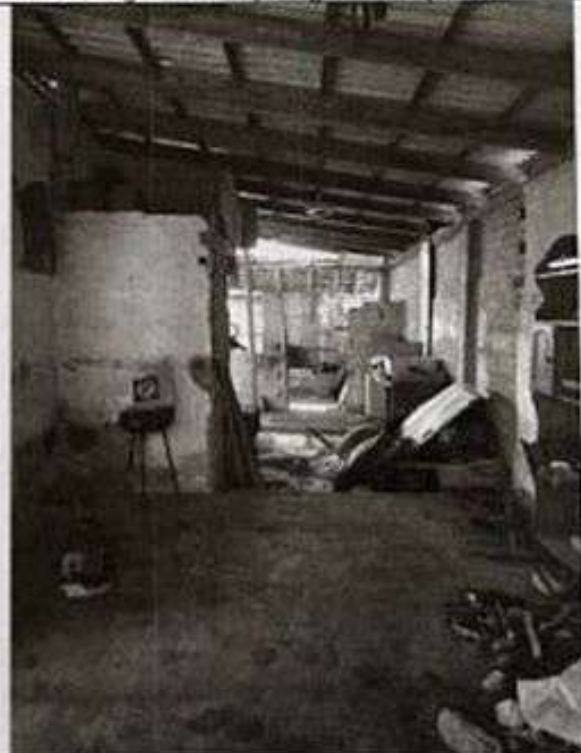
Immagine 20 - Vista interna del blocco accessorio (comprensivo dell'originaria autorimessa)
