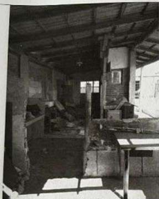
Immagine 25 - Vista interna del blocco accessorio
