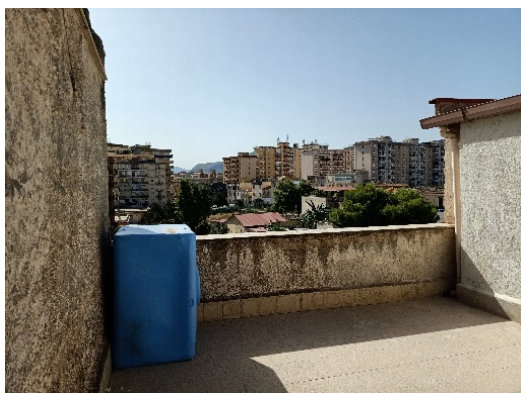
Terrazzo di copertura (su retro prospetto)
