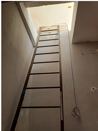
Scala a pioli e botola d'accesso al P. coperture
