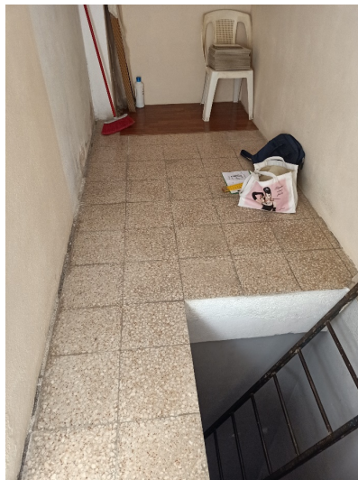
Locale di sgombero al 3° P. (piano coperture)
