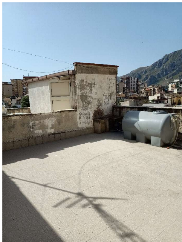
Foto n.31 – terrazzo di copertura
