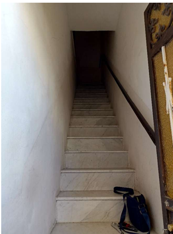
Foto n.4 – rampa vano scala dal piano terra
