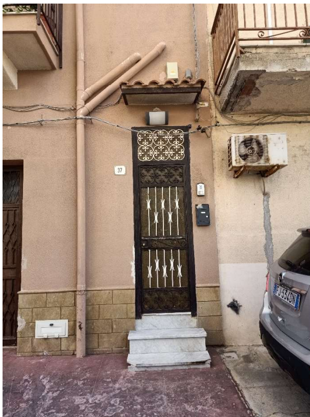
Foto n.2 – Accesso al vano scala del civico n°37
