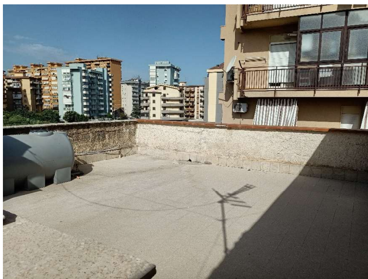
Foto n.32 – terrazzo di copertura
