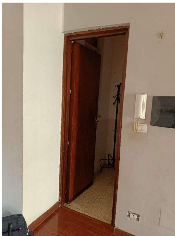
Foto n.17 – porta d'accesso al 2° piano
