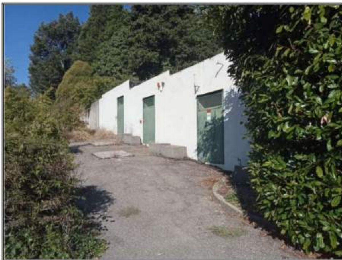
FOTO N° 6 (ETSERNO CABINA ELETTRICA E TRASFORMATORI)
