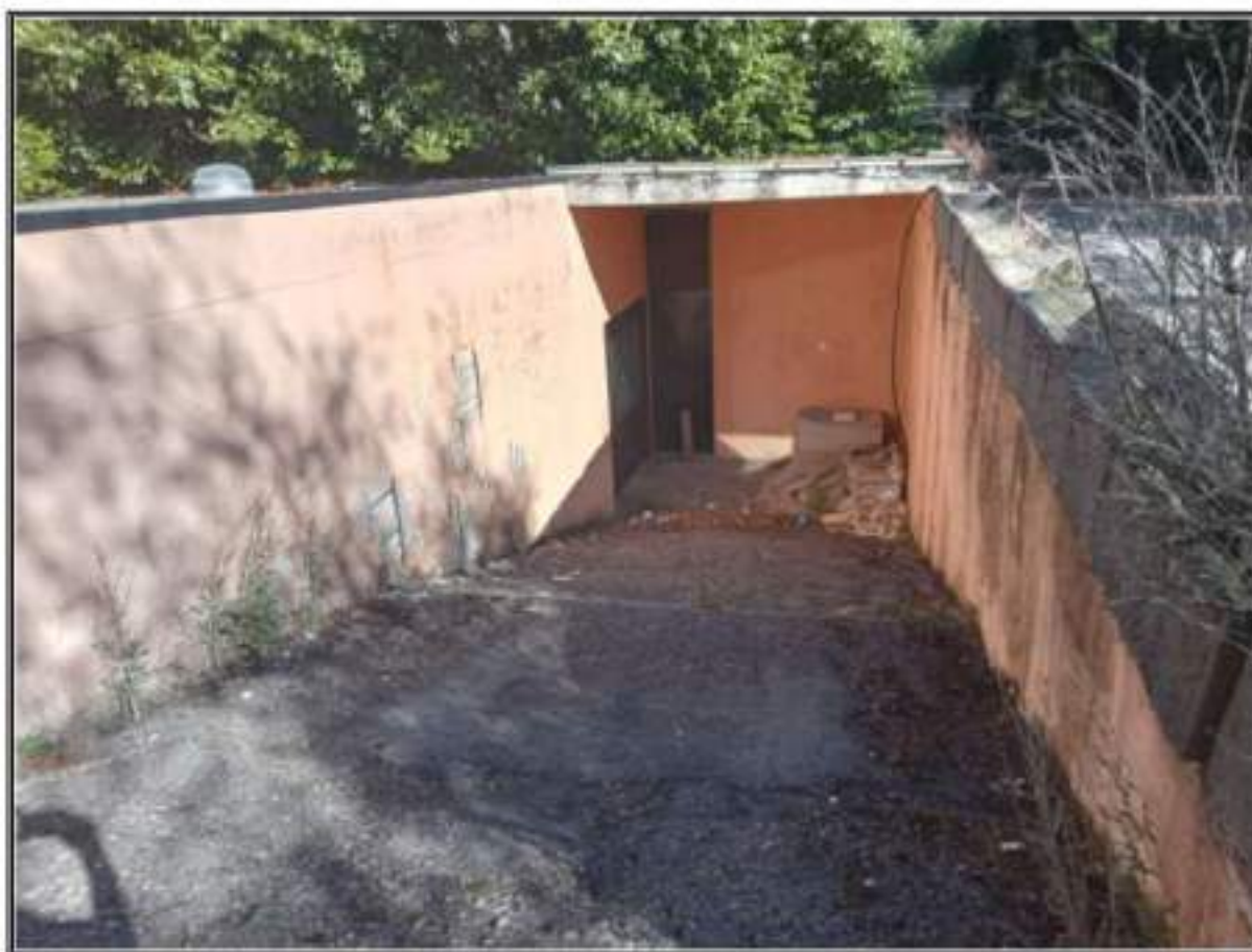
FOTO N° 10 (RAMPA DI ACCESSO AL PIANO SEMINTERRATO)
