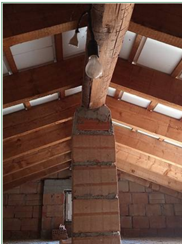
Dettaglio copertura : Struttura lignea in più che buone condizioni generali e coibentazione del manto di copertura. Pavimento lasciato al grezzo.
