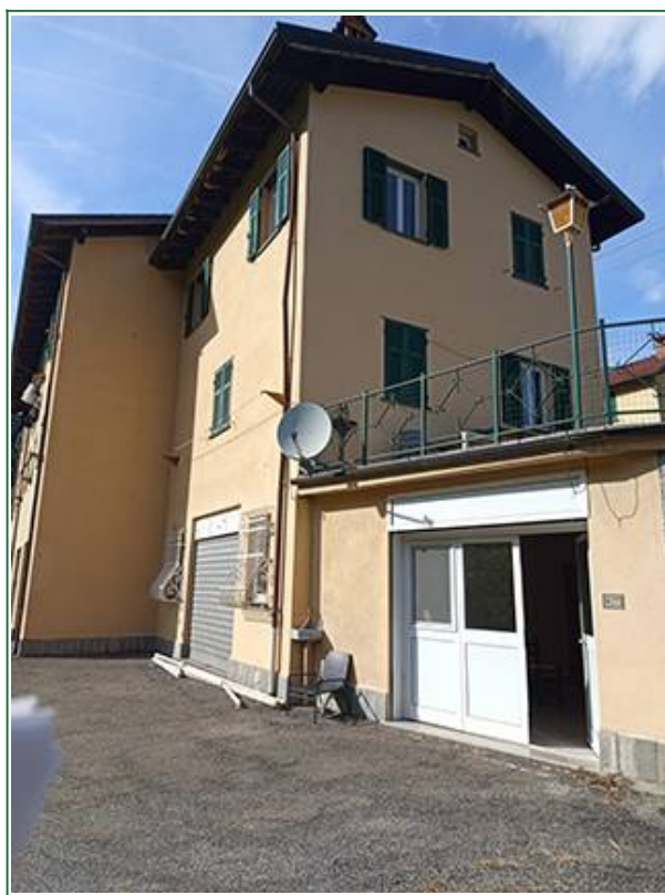
vista dalla corte interna comune
