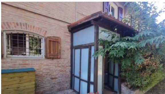
Veranda fronte Nord
