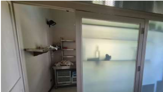
Disimpegno alla Sala da pranzo Piano Primo
