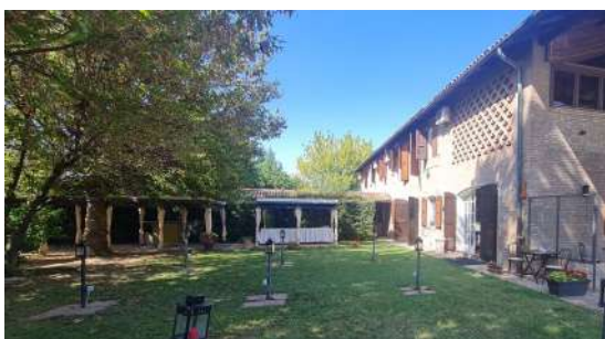
Area cortiliva fronte Sud Est
