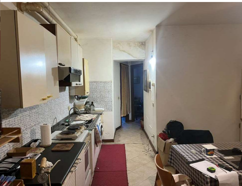
Piano T – Sub.1 – Area soggiorno – angolo cucina
