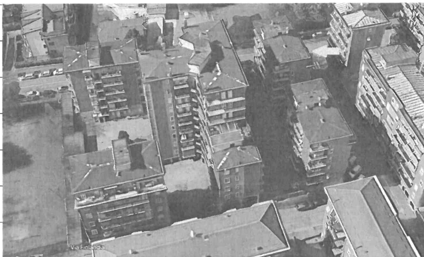
Vista aerea del complesso – Google Earth –
