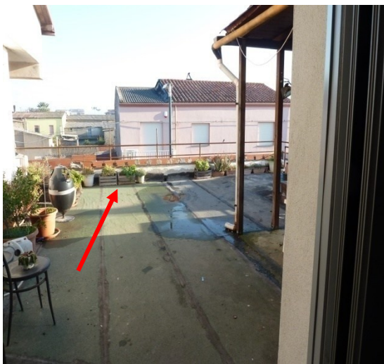
Foto n 4 terrazza e sbocco scala
