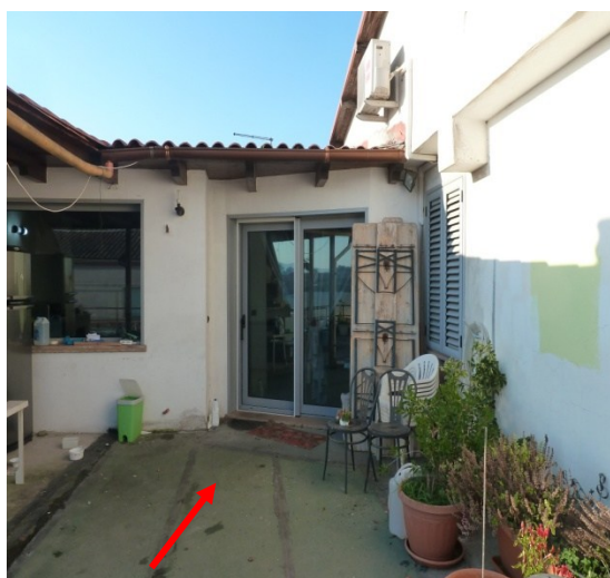
Foto n 6 ingresso
