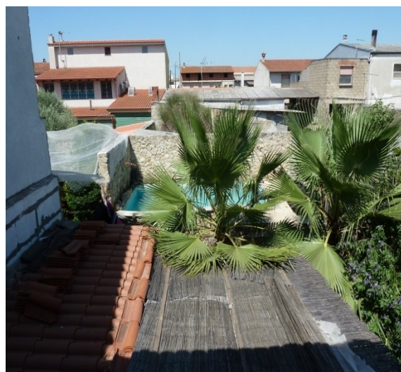
Foto n. 25 coperture e vista piscina
