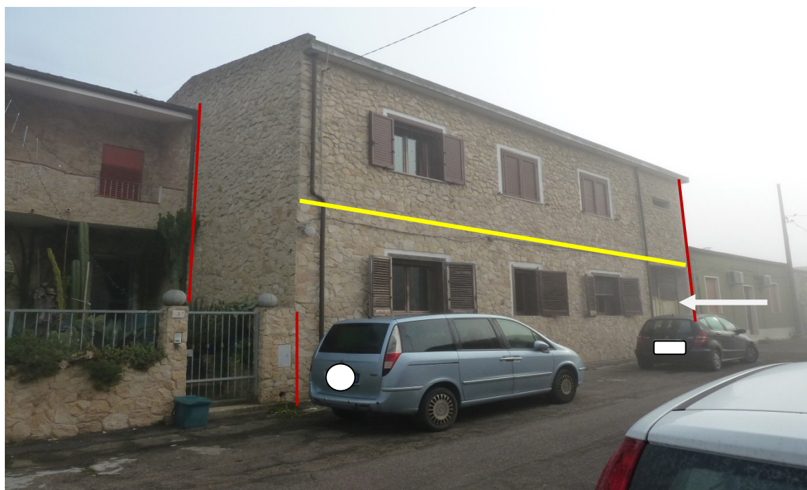
Foto n. 1 prospetto principale sulla via Satta
