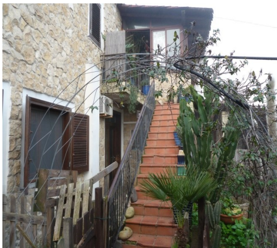
Foto n 1 scala di accesso
