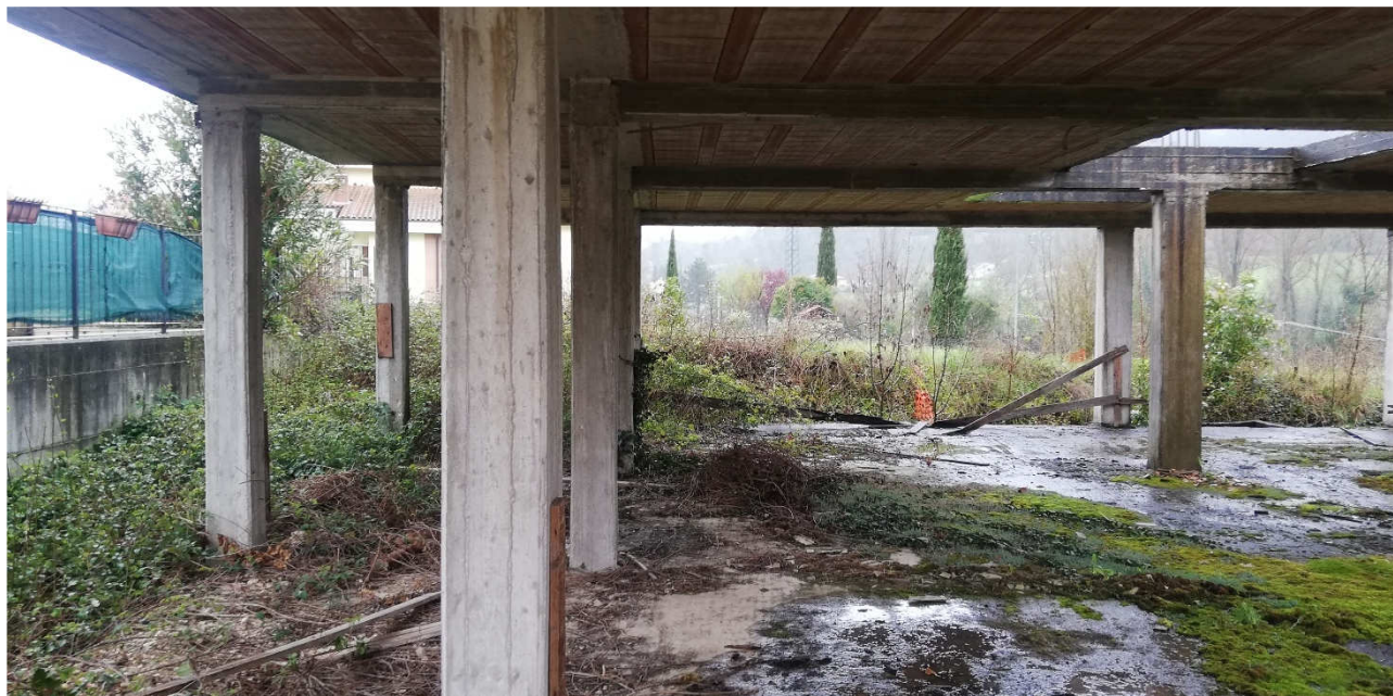
6) Vista all'interno della struttura al piano terra
