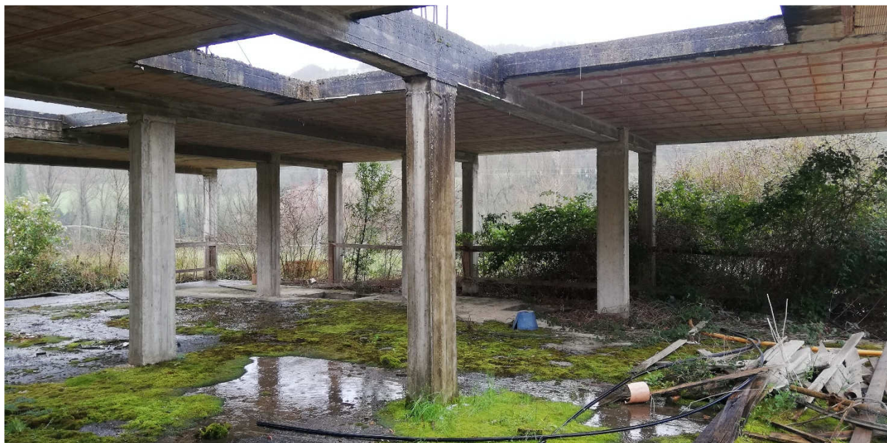
5) Vista all'interno della struttura al piano terra
