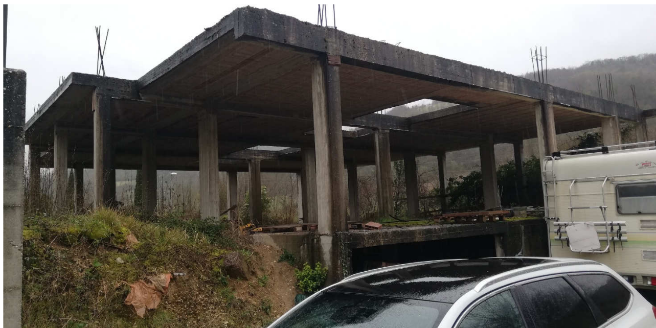
3) Vista della struttura in corso di costruzione
