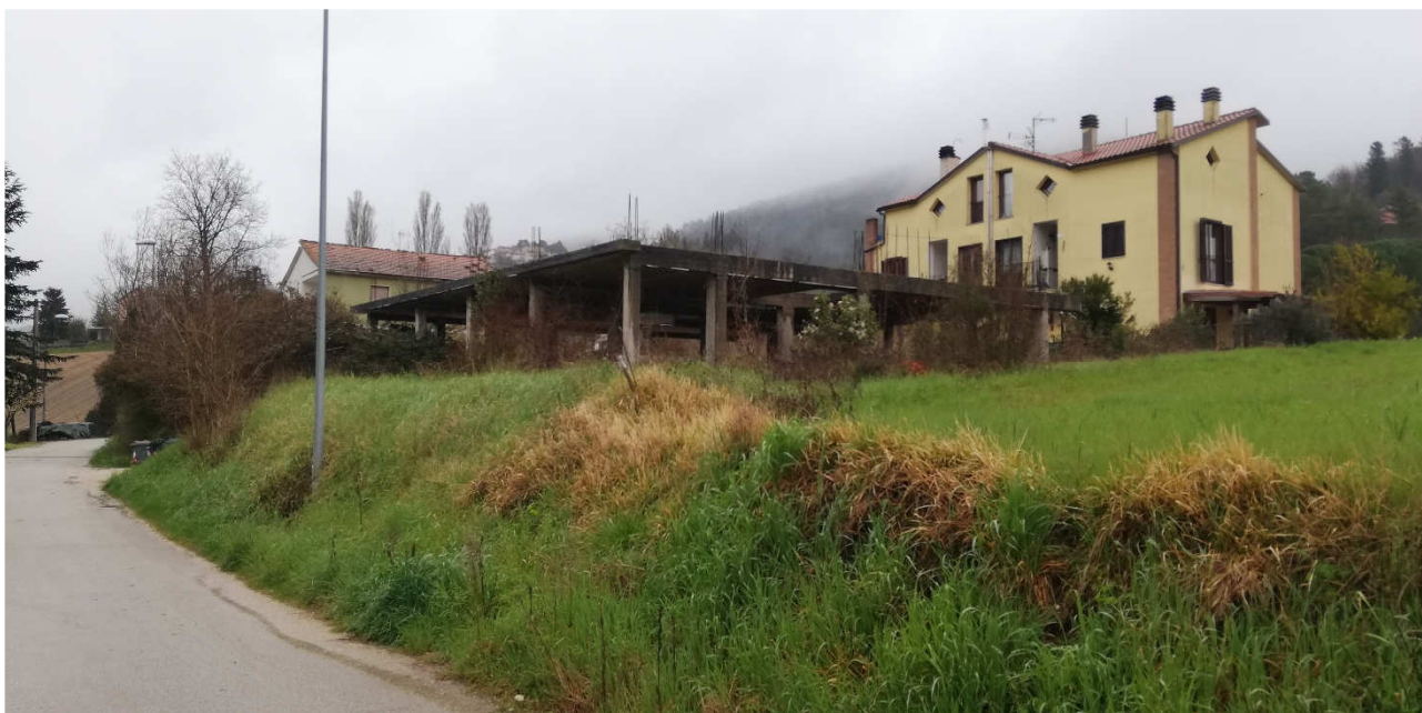
1) Vista dell'area del lotto e del fabbricato in costruzione dalla strada del Prato
