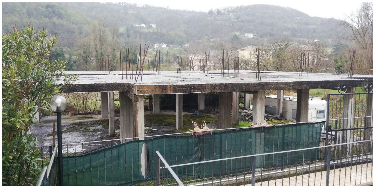
4) Vista della struttura in corso di costruzione, dalla corte dell'edificio a monte
