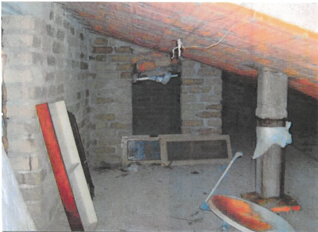
Foto n. 23 – Interno del sottotetto avente accesso dall'abitazione del piano primo – LOTTO N. 2 - sita in Lariano (Rm) Piazzale Martiri della Libertà n. 5
