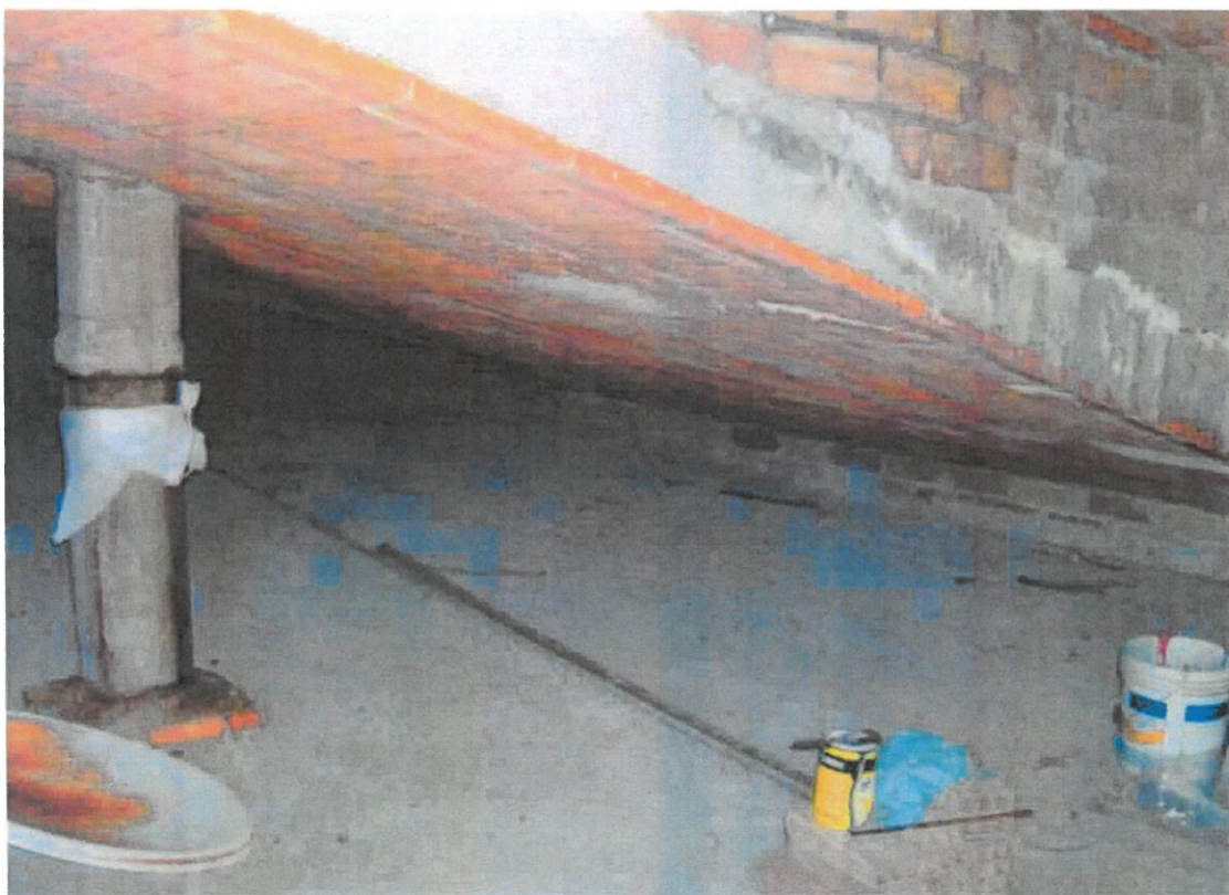
Foto n. 24 – Interno del sottotetto avente accesso dall'abitazione del piano primo – LOTTO N. 2 - sita in Lariano (Rm) Piazzale Martiri della Libertà n. 5
