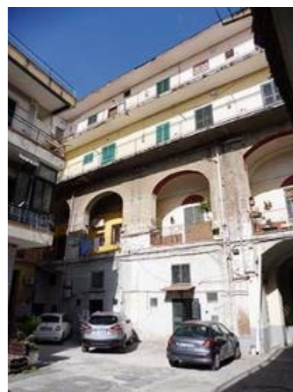
_androne e vista interna del Fabbricato dal cortile
