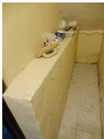
_soggiorno e ripostiglio nel sottoscala
