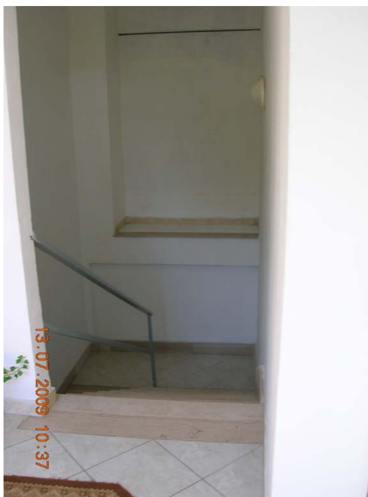
Foto 17. Scala di collegamento
