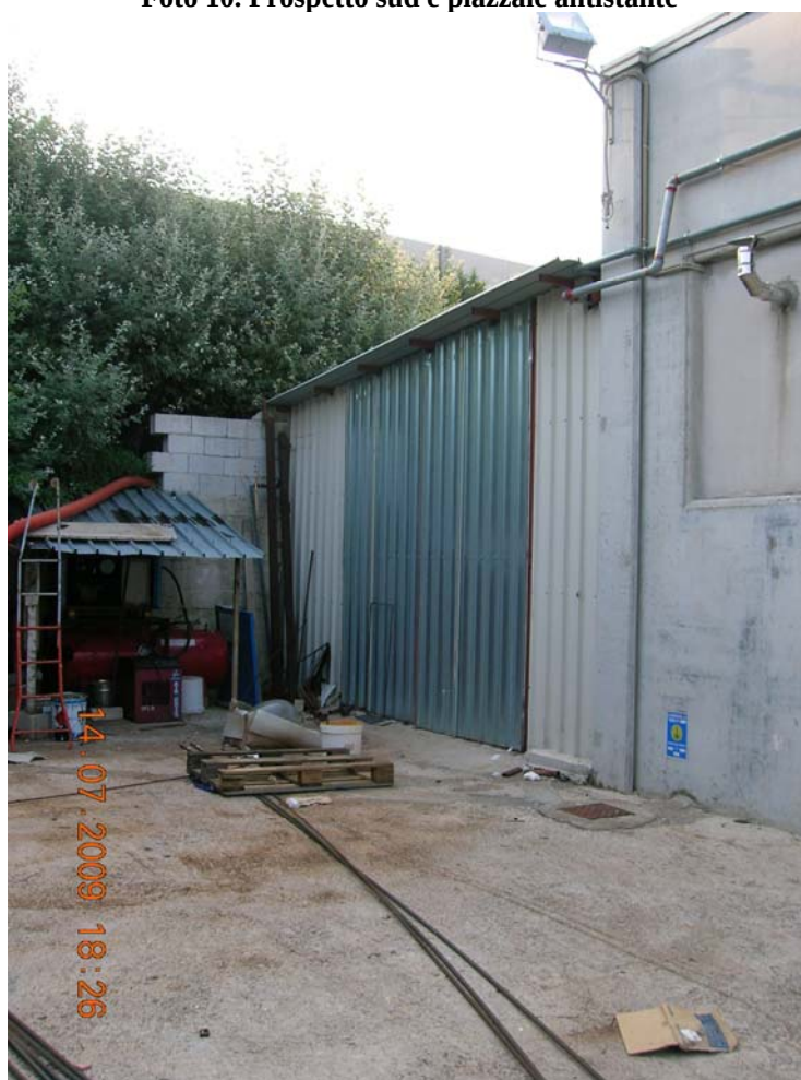
Foto 11, 12, 13, 14. Corpo estraneo alla struttura principale dell'opificio
