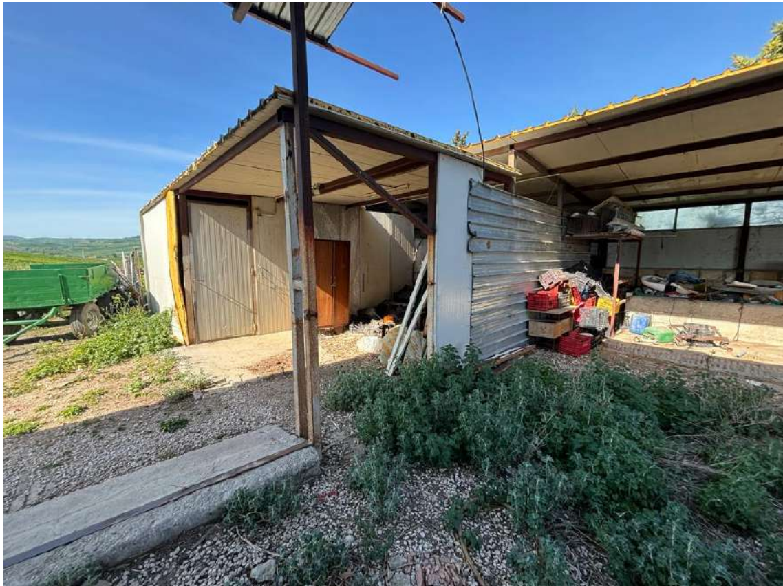
Foto n. 17 – Particolari del fabbricato fgl 22, p.lla 138 sub 1
