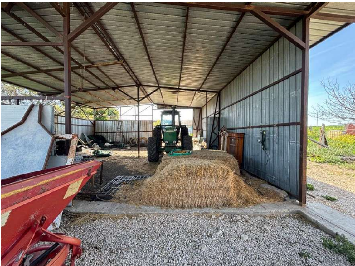
Foto n. 20 – Particolari del fabbricato fgl 22, p.lla 138 sub 1
