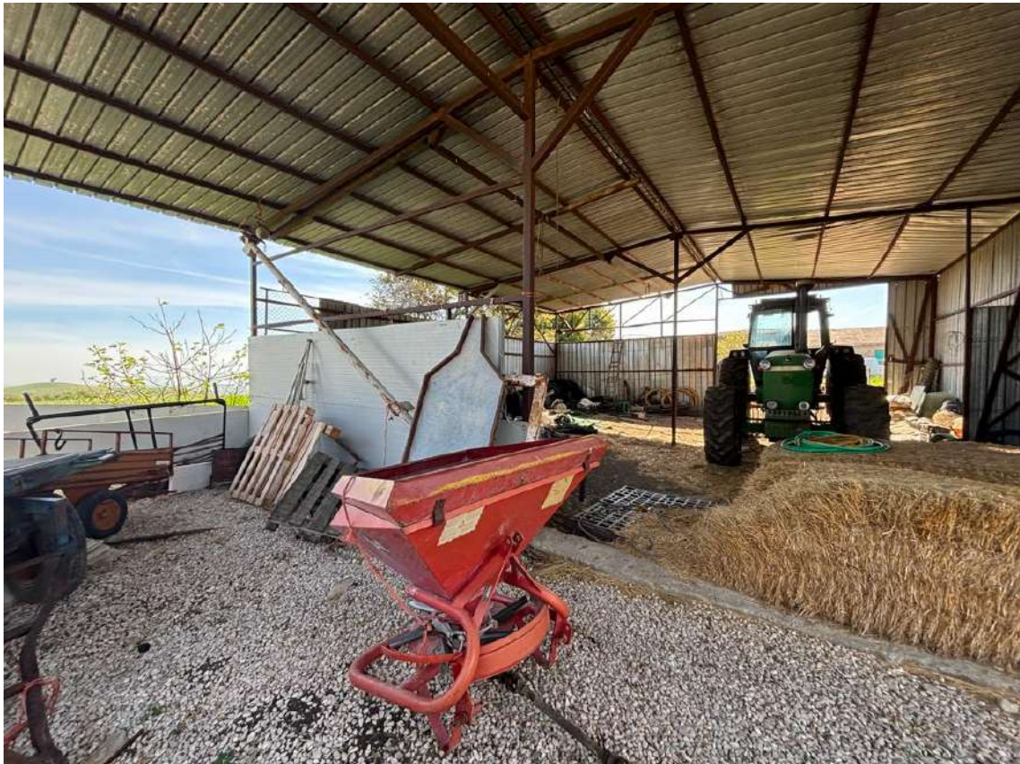
Foto n. 19 – Particolari del fabbricato fgl 22, p.lla 138 sub 1
