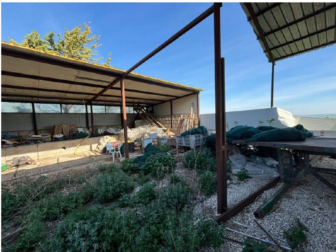
Foto n. 18 – Particolari del fabbricato fgl 22, p.lla 138 sub 1
