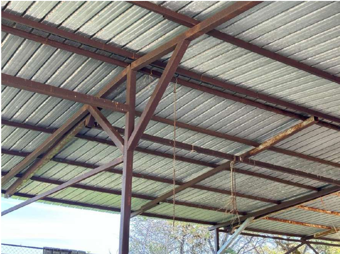
Foto n. 21 – Particolari strutturali del fabbricato fgl 22, p.la 138 sub 1
