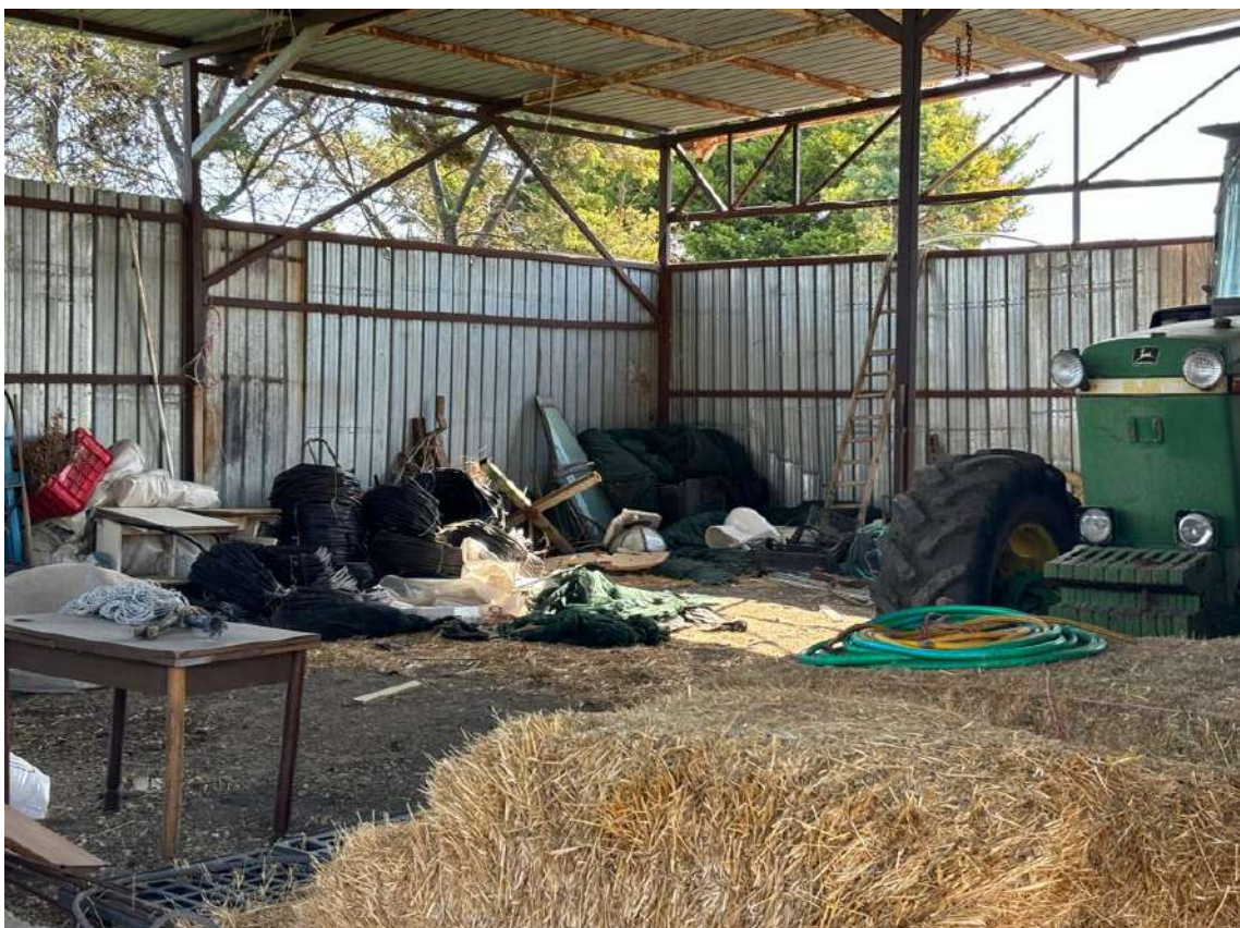
Foto n. 22 – Particolari strutturali del fabbricato fgl 22, p.la 138 sub 1
