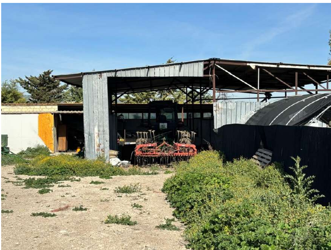
Foto n. 24 – Prospetto del fabbricato fgl 22, p.lla 138 sub 1
