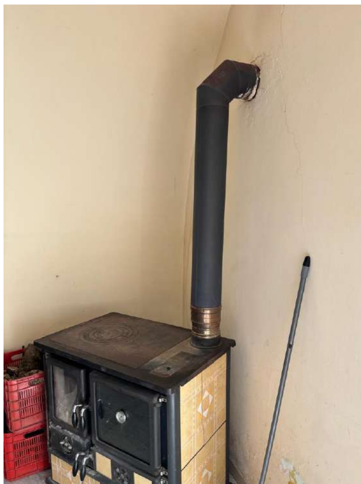
Foto n. 34 – Particolare interno dell'immobile fgl 22, p.la 145 (ex 117)
