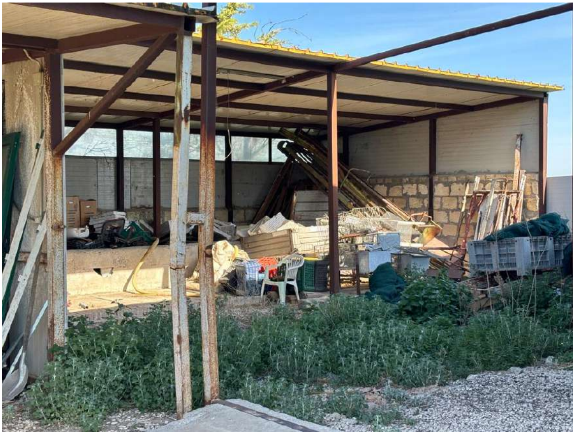
Foto n. 23 – Particolari strutturali del fabbricato fgl 22, p.lla 138 sub 1
