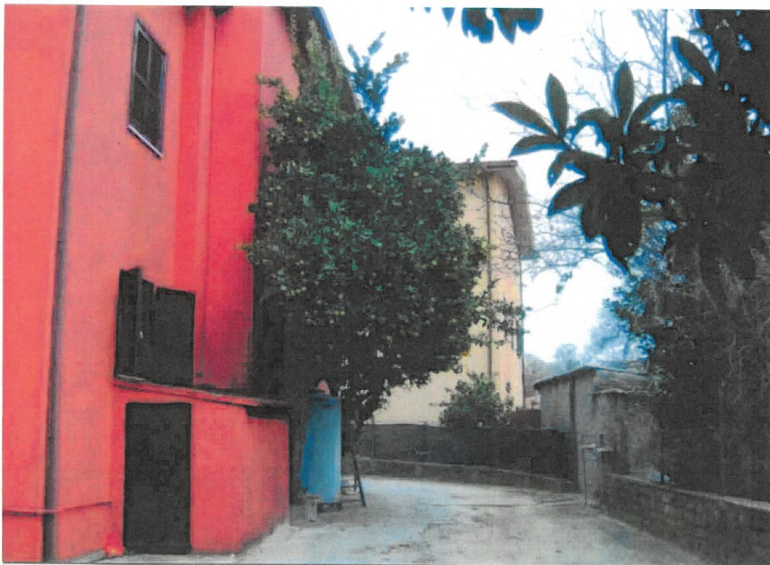
Foto n. 4 – Esterno del negozio (piano terra – LOTTO N. 1 ) e dell'abitazione (piano primo – LOTTO N. 2 ) siti in Lariano (Rm) – Piazzale Martiri della Libertà n. 5 – corte comune
