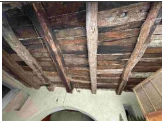
Particolare solaio locale terraneo sub 10
