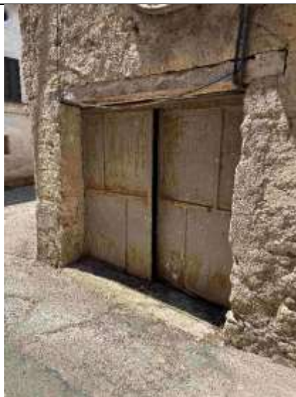
Ingresso locale terraneo p.lla 239 sub 3
