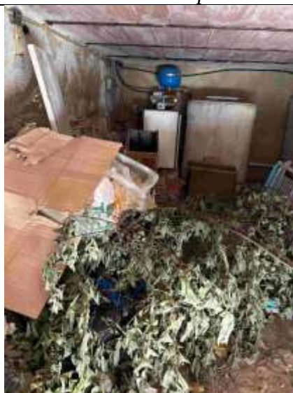
Interno locale p.lla 239 sub 3
