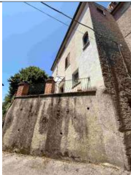
Vista esterna fabbricato
