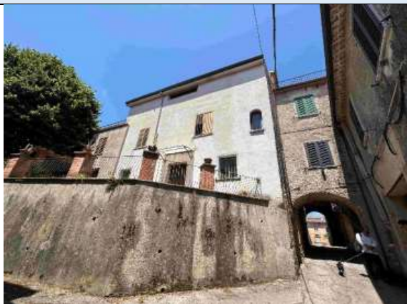
Vista esterna fabbricato
