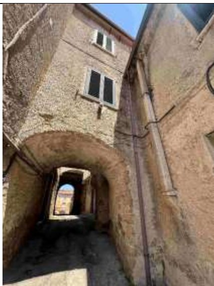
Vista esterna fabbricato
