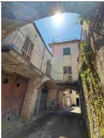
Vista esterna fabbricato
