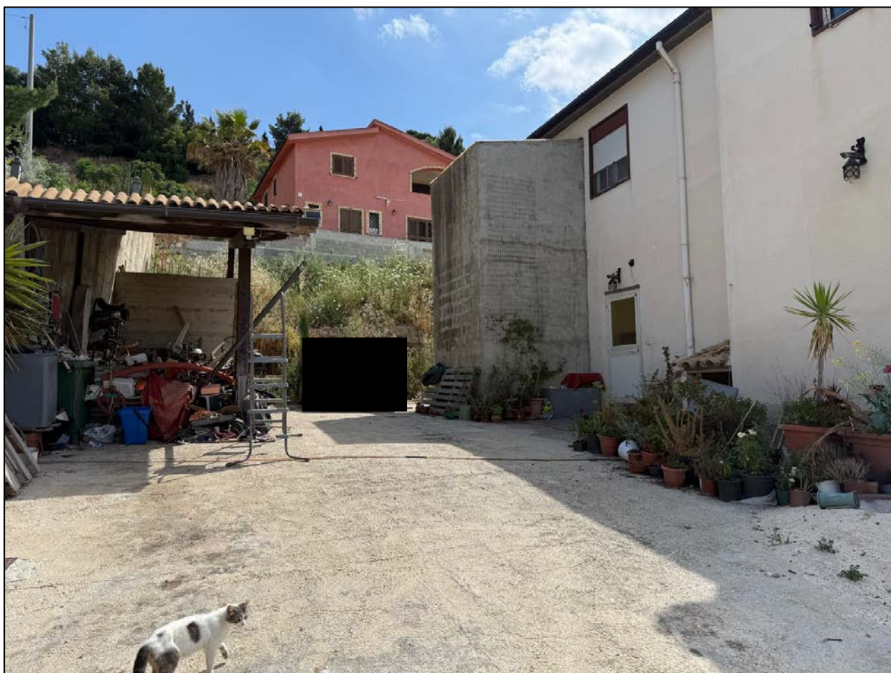
FIGURA 5: PARTICOLARE DELL'INGRESSO, DELLA SCALA ESTERNA E DI UNA DELLE PERGOLE AUTORIZZATE SUCCESSIVAMENTE ALLA COSTRUZIONE
