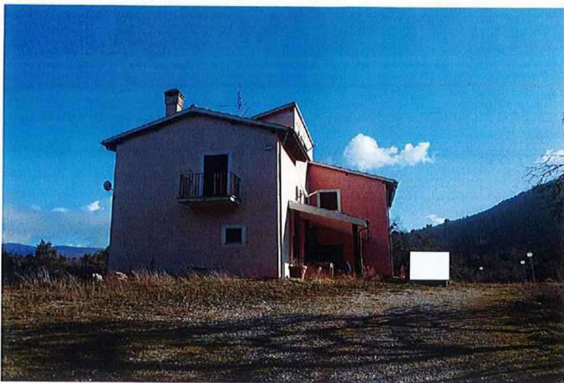
Vista edificio fianco sx blocco 1 dall'arrivo della viabilità
