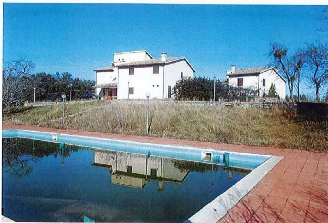
Vista complessiva edificio dalla zona piscina
