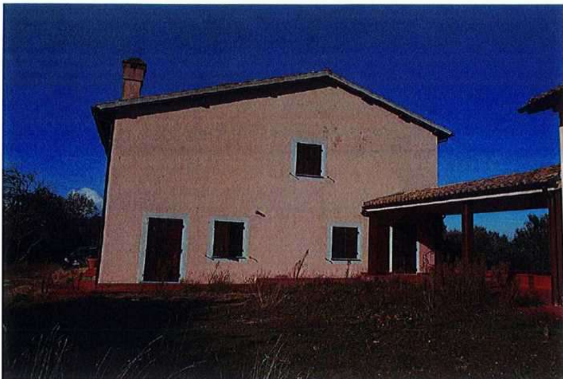
Vista parziale edificio blocco 1 - fianco dx e congiunzione con blocco 2
