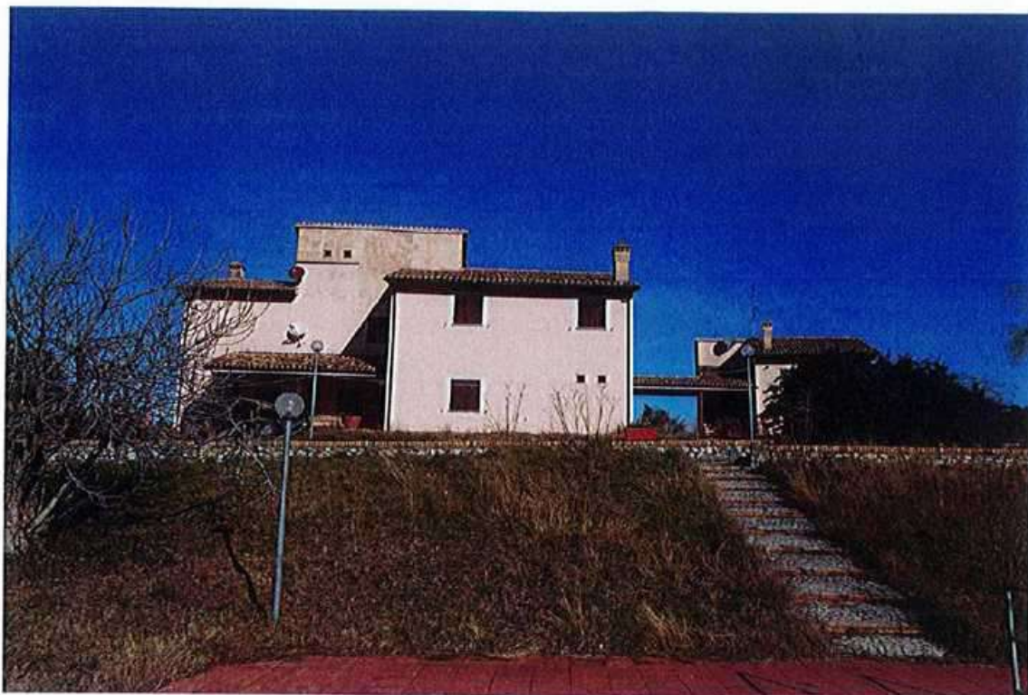
Vista complessiva edificio dalla zona piscina
