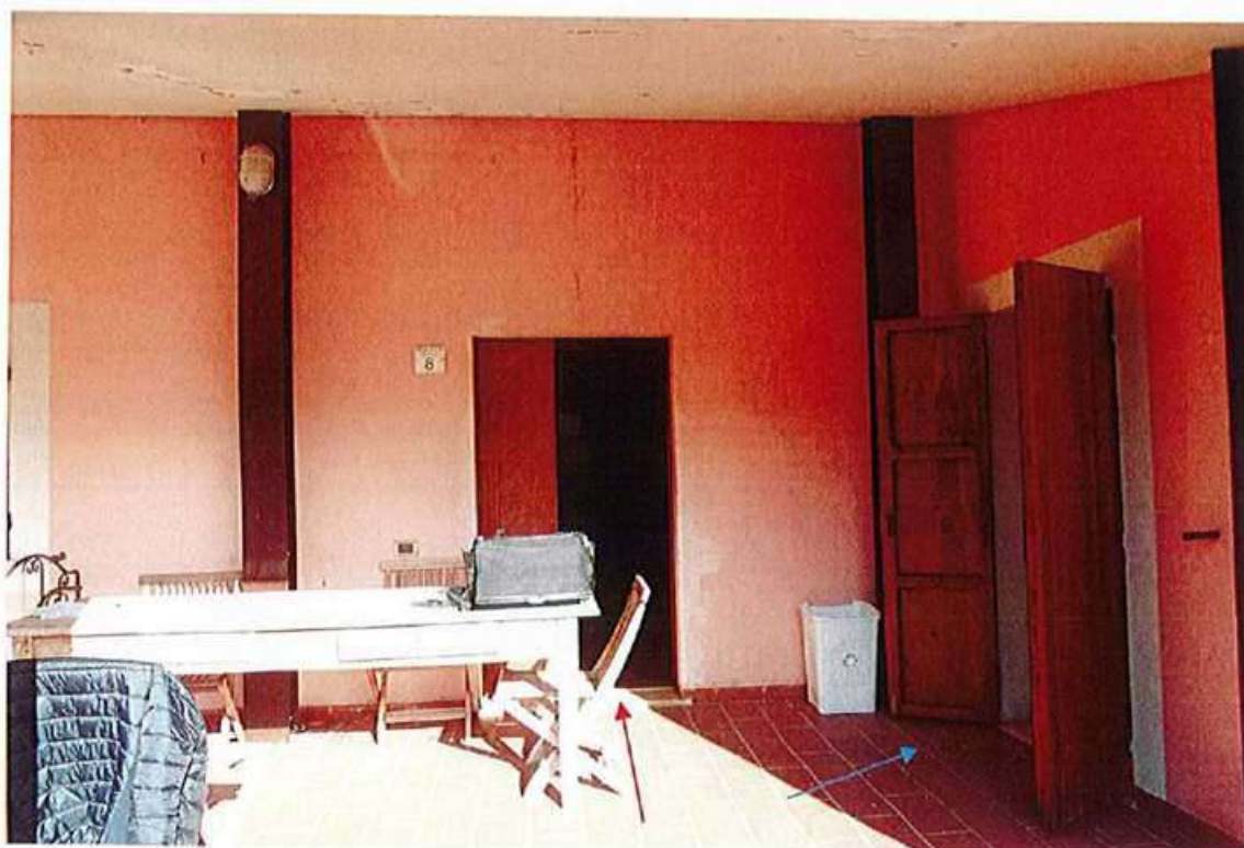
Ingresso salone e cucina dal portico
