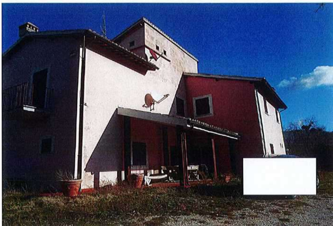
Vista parziale edificio blocco 1 – lato fronte
