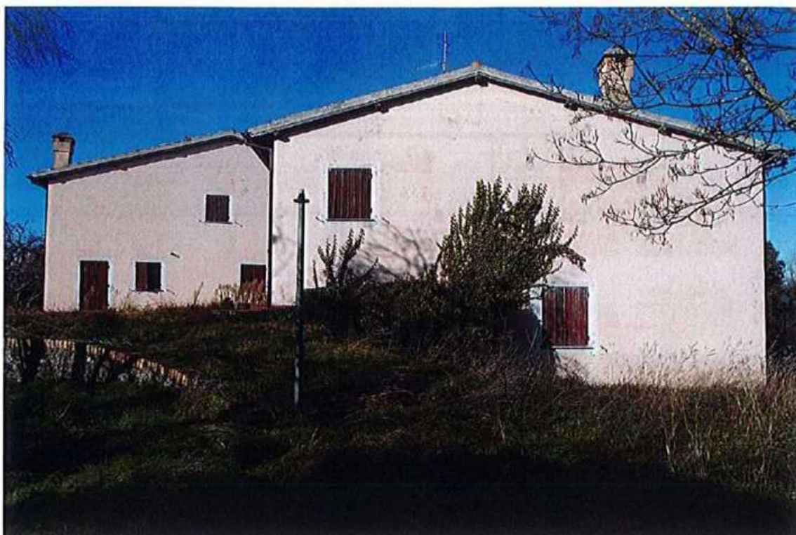
Vista parziale edificio (blocchi 1 e 2 ) fianco dx
