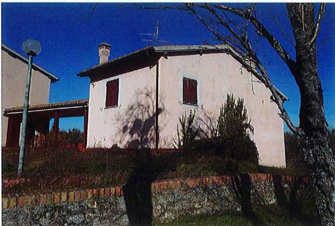
Vista parziale edificio blocco 2 - fianco dx e fronte - congiunzione con blocco 1
