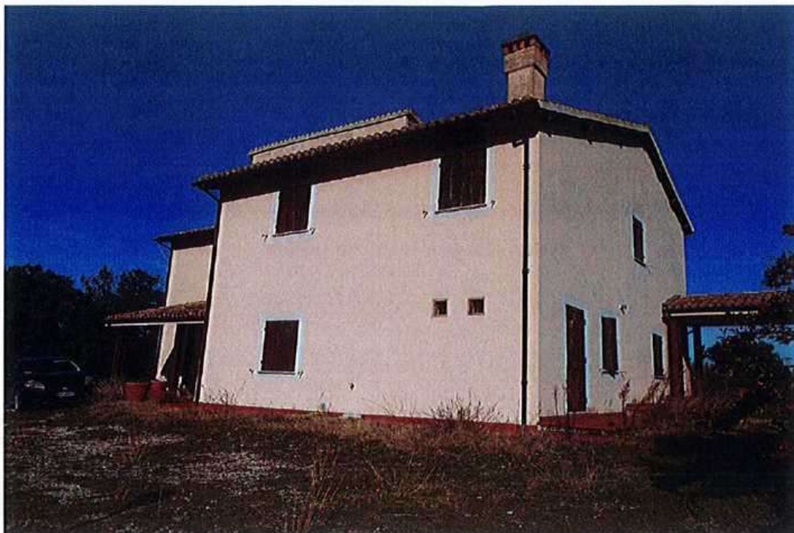
Vista parziale edificio blocco 1 – lato fronte
