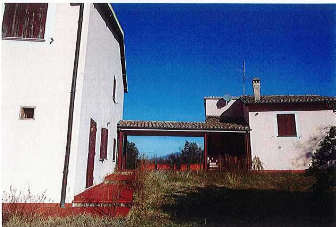
Lato fronte – congiunzione blocchi 1 e 2
