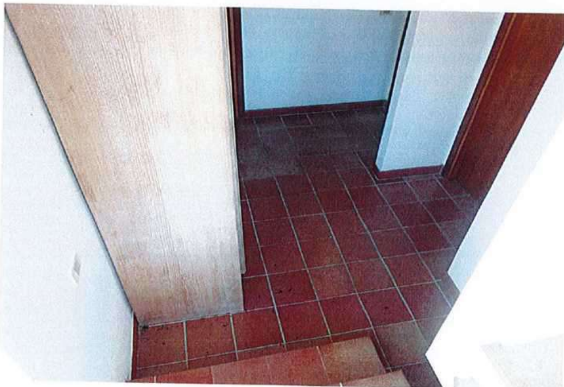
Arrivo scala al piano terra
