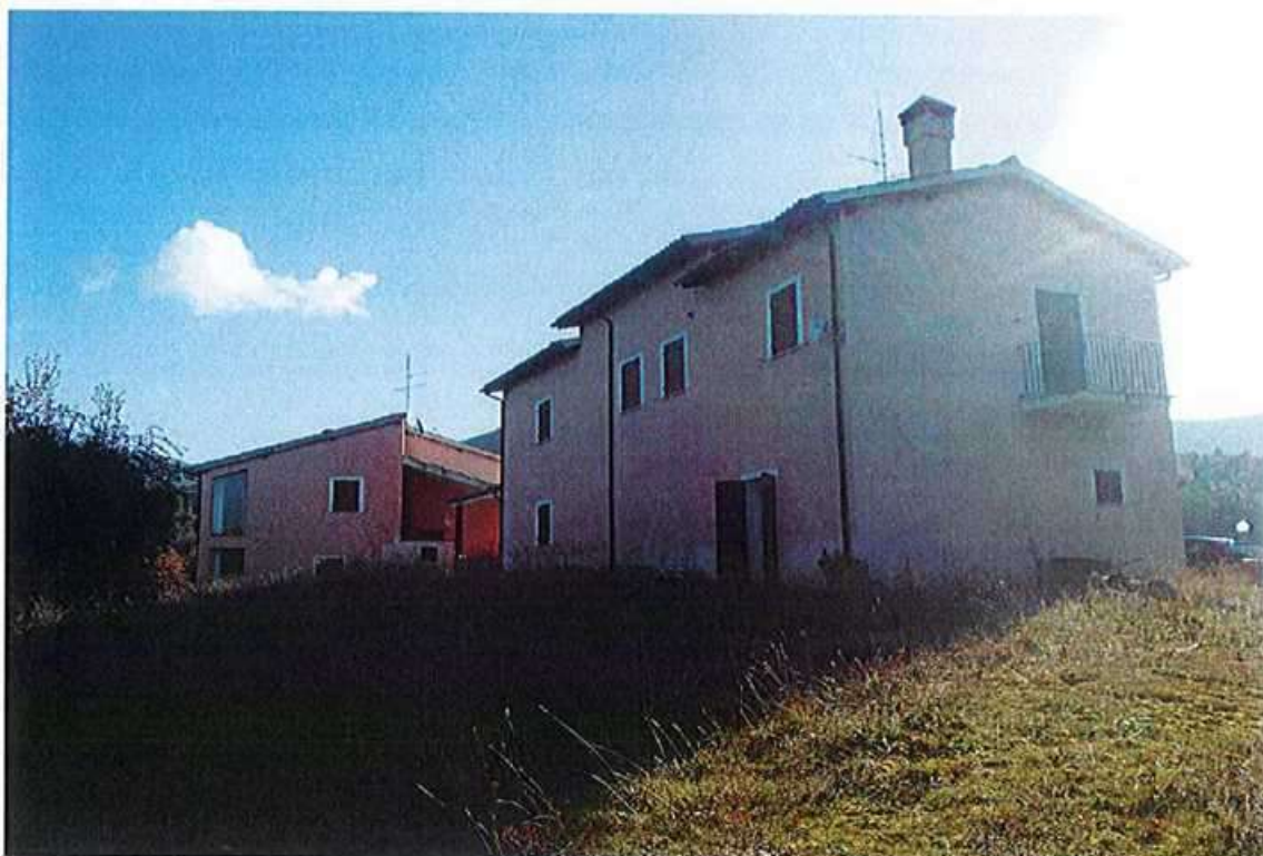
Vista complessiva edificio fianco sx r lato retro
