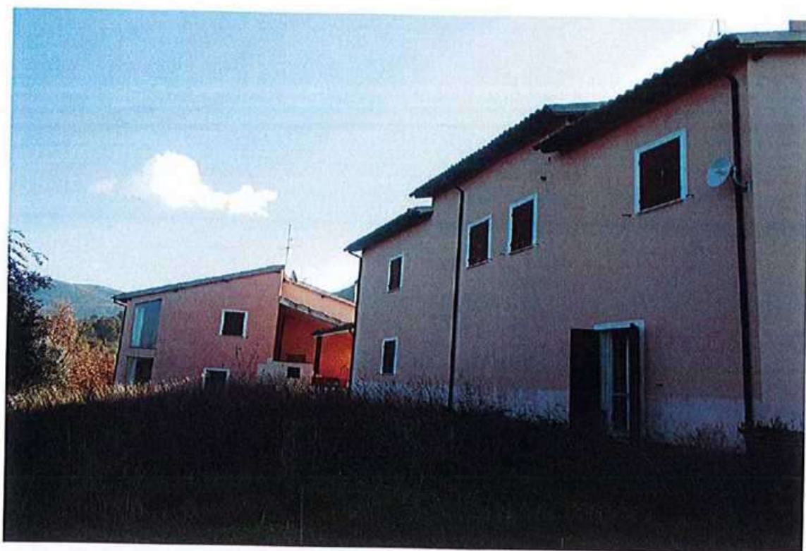
Vista complessiva edificio lato retro
