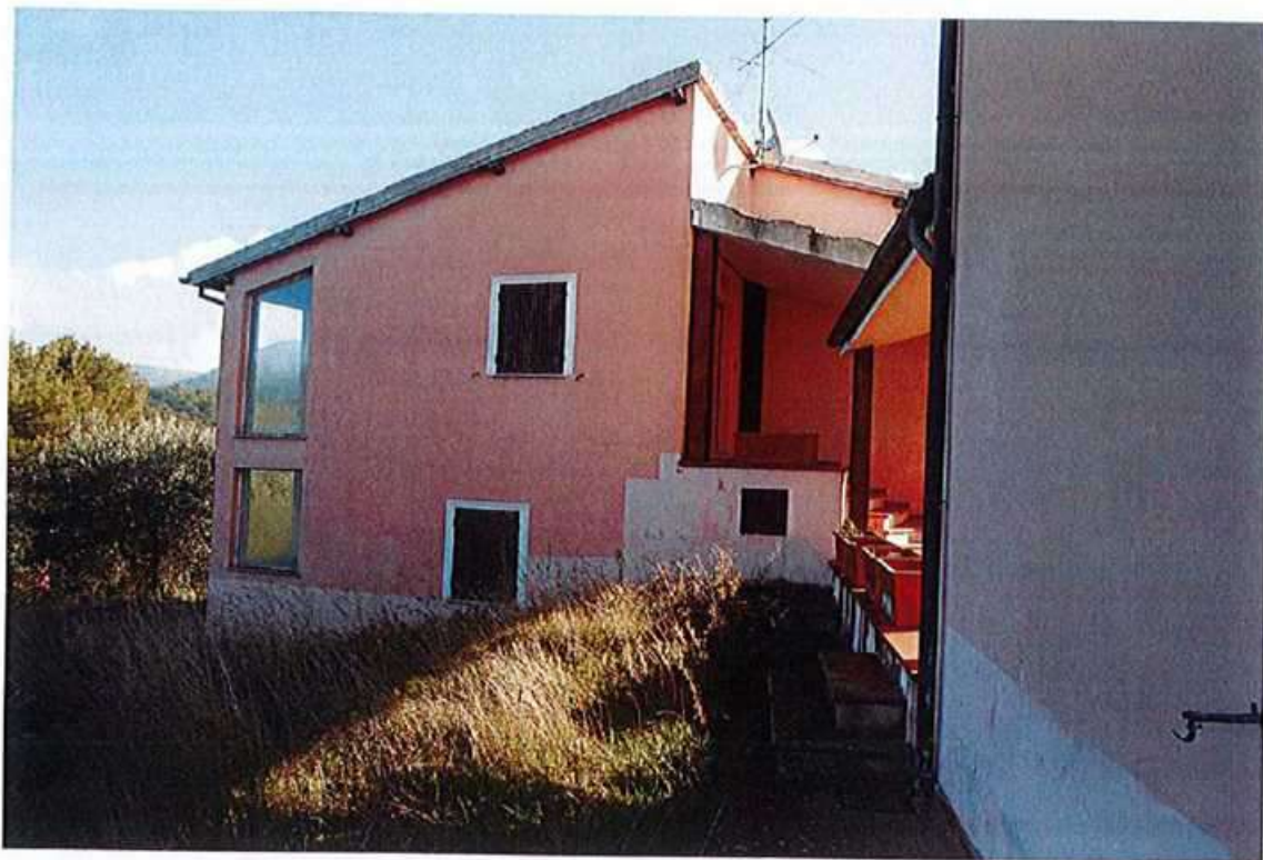
Vista parziale edificio lato retro blocco 2
