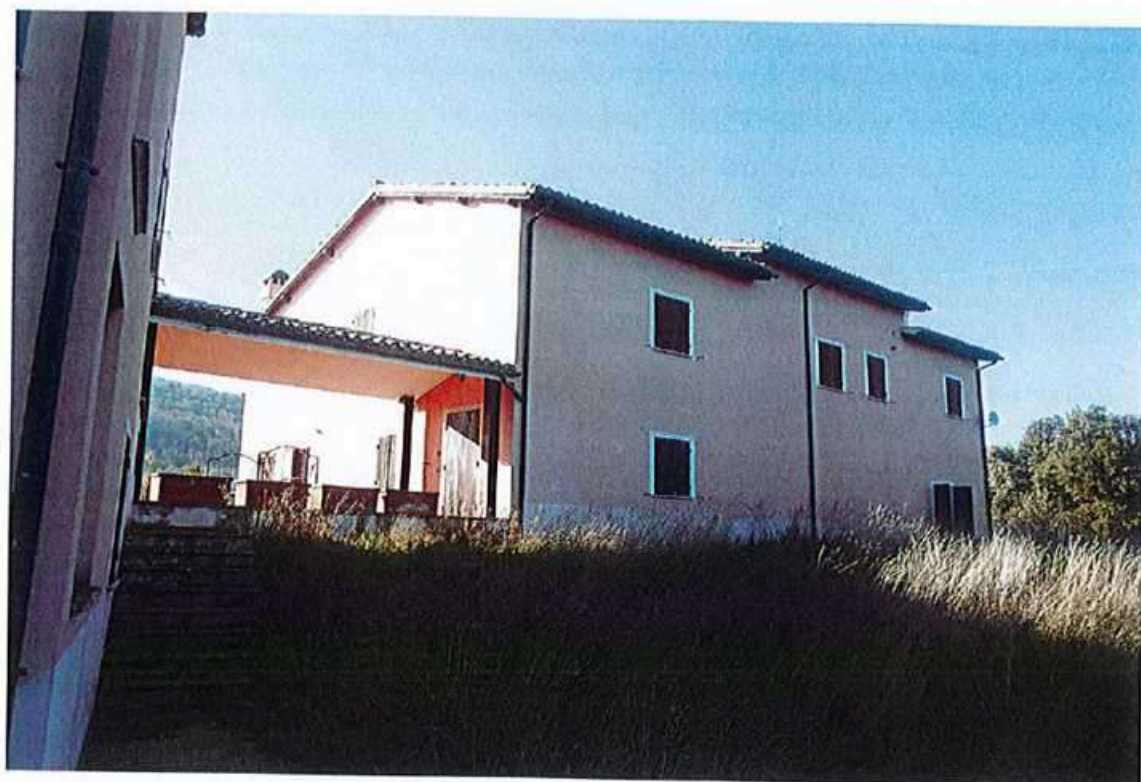
Vista parziale edificio lato retro e congiunzione blocchi 1 e 2
