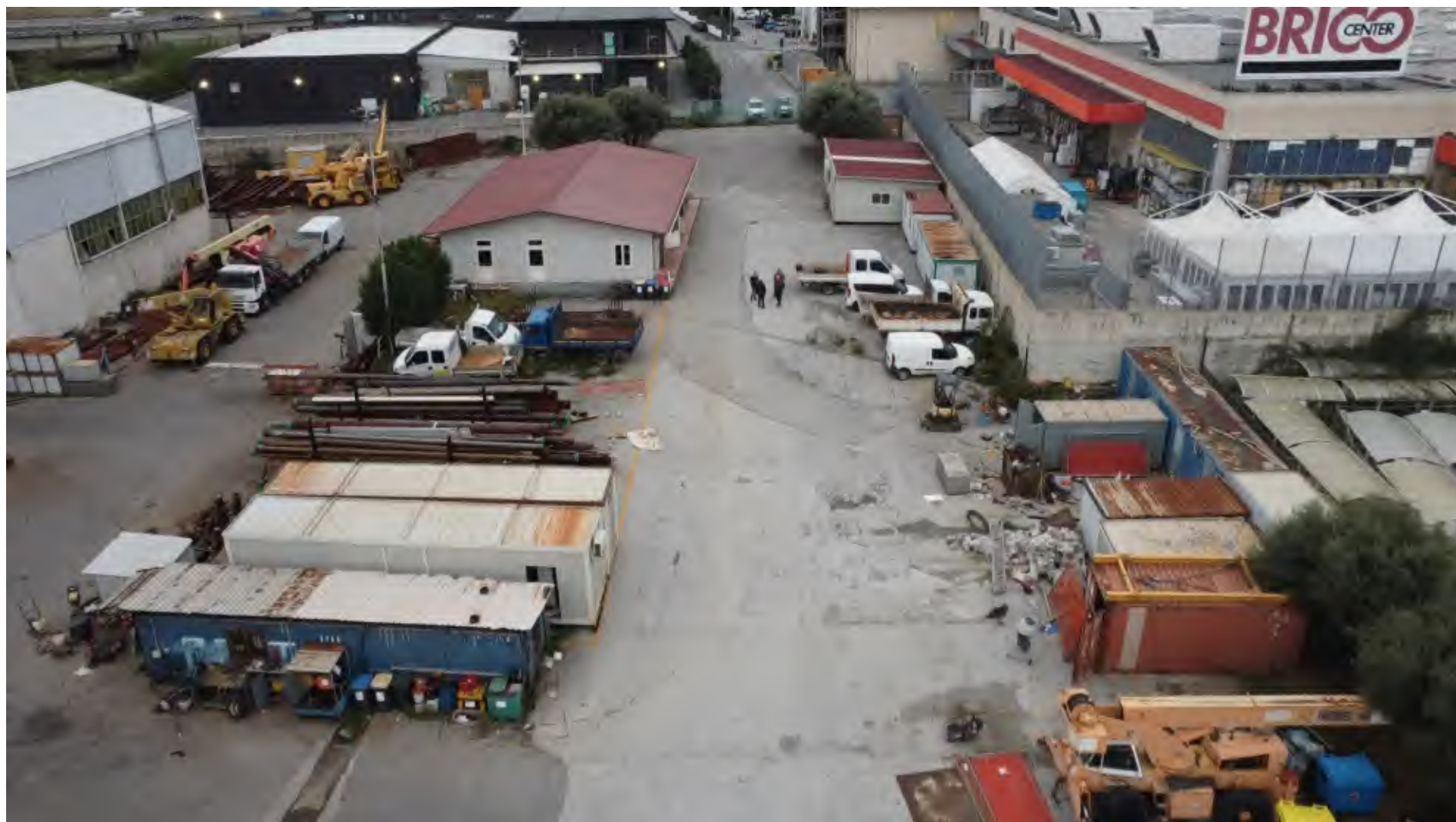
Figure 3 - vista aerea piazzale di deposito e al centro il Corpo A
