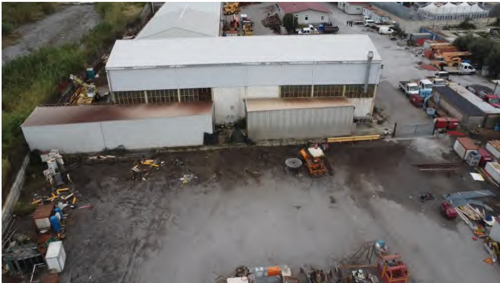
Figure 5 - vista aerea dei corpi abusivi aggiunti al Capannone 1
