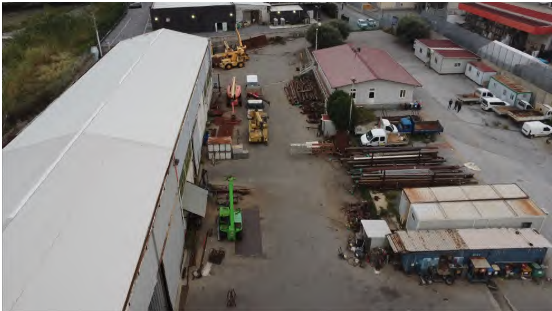
Figure 2 - vista aerea: a sinistra capannone 2, 3 e al centro il Corpo A
