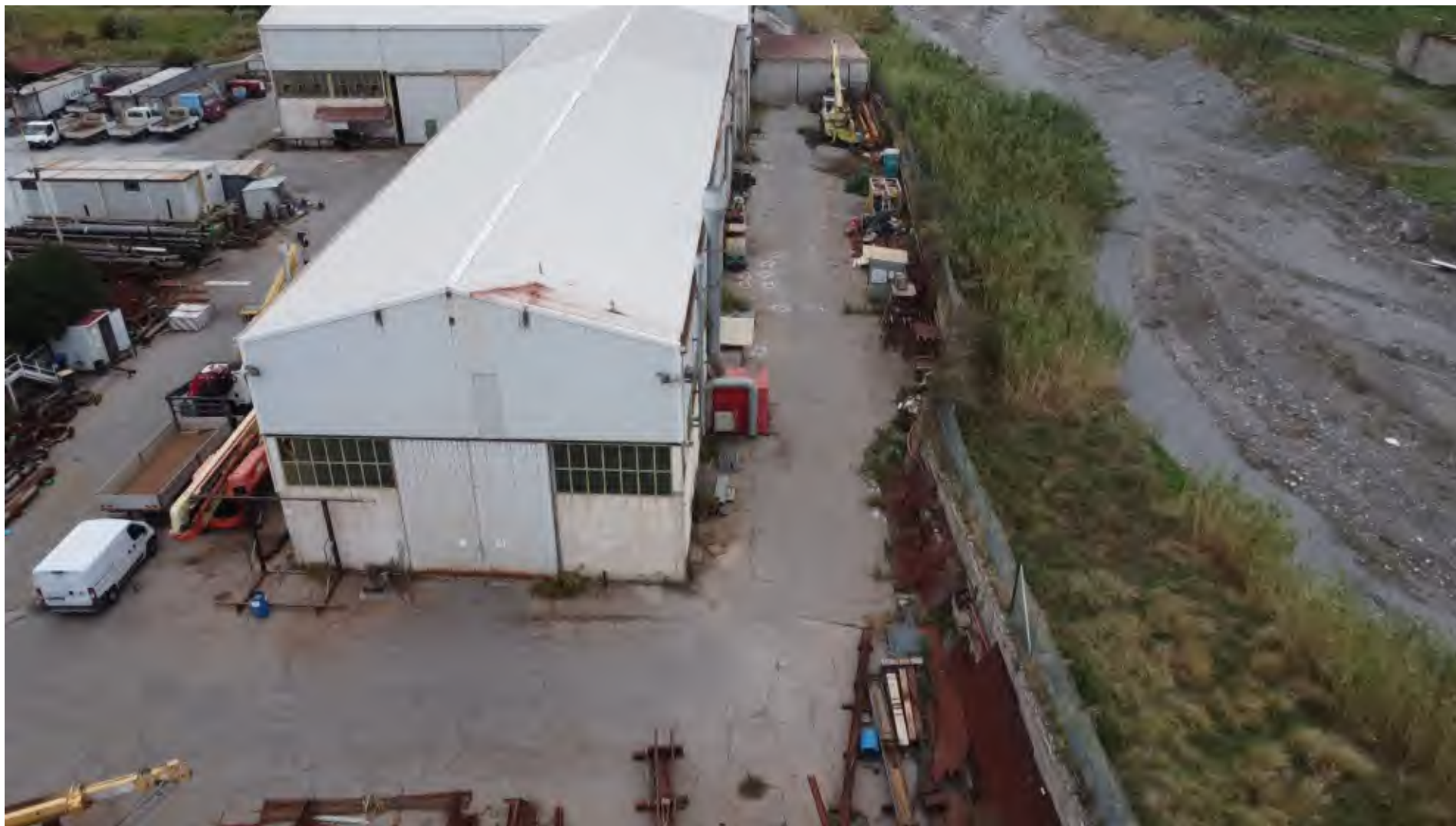
Figure 6 - vista aerea: in primo piano il Capannone 2 e a seguire il 3 e l'1
