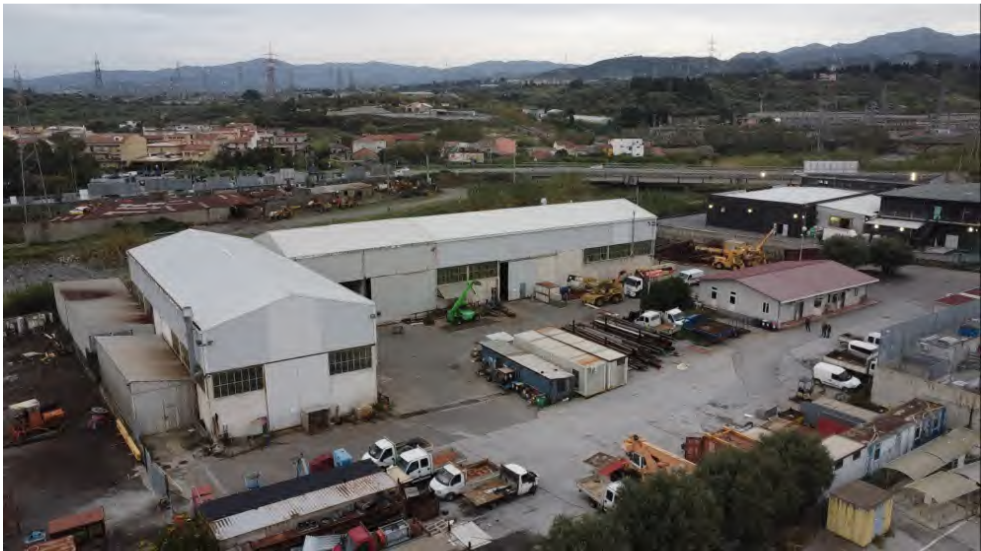
Figure 1 - vista aerea Capannoni 1,2,3 e Corpo A
