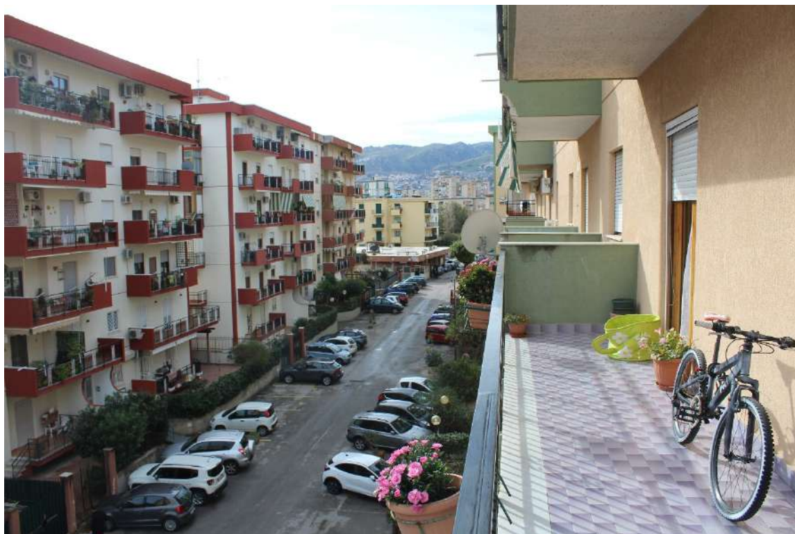
Foto n. 31 – Balcone su prospetto principale
