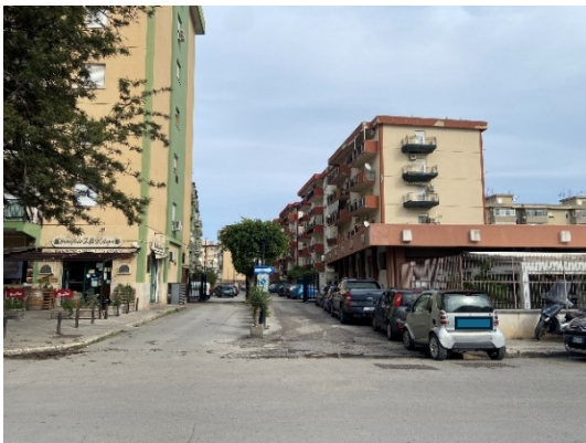
Ingresso al complesso condominiale
