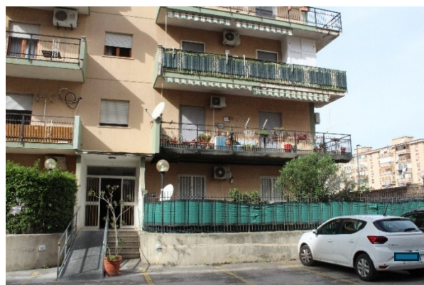
Ingresso all'edificio C
