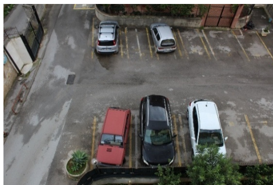
Prospetto su corte interna (posti auto assegnati)
