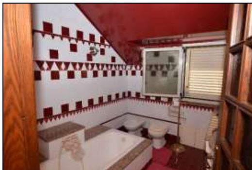
All. 13 – Foto 31 Wc bagno (3)
