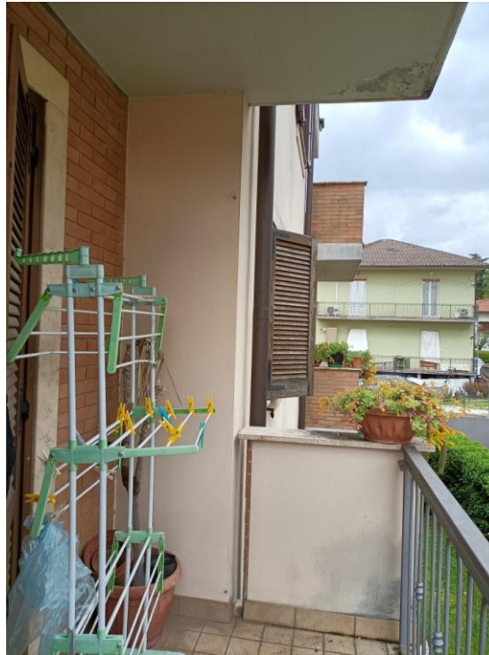
Fotogramma n. 23 Balcone Lato Nord
