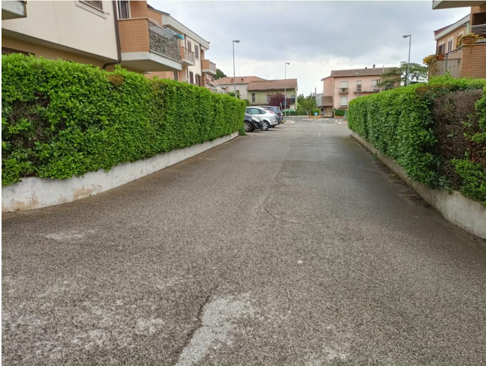
Fotogramma n. 9 Strada Lato Nord
