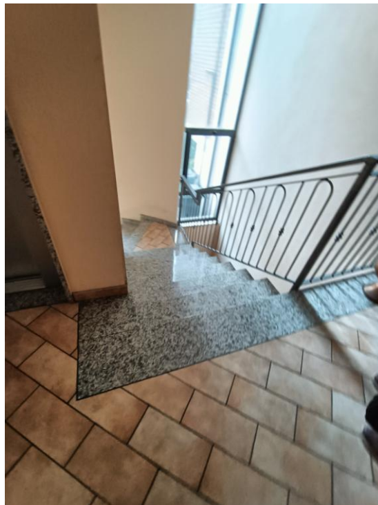
Fotogramma n. 12 Vano Scala Condominiale
