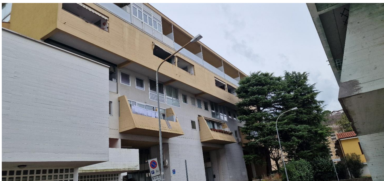
Foto n. 4 – Facciata laterale dell' edificio
