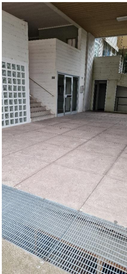
Foto n. 5 – Area esterna d’ingresso dell’edificio civ. n. 24 – vista n.1
