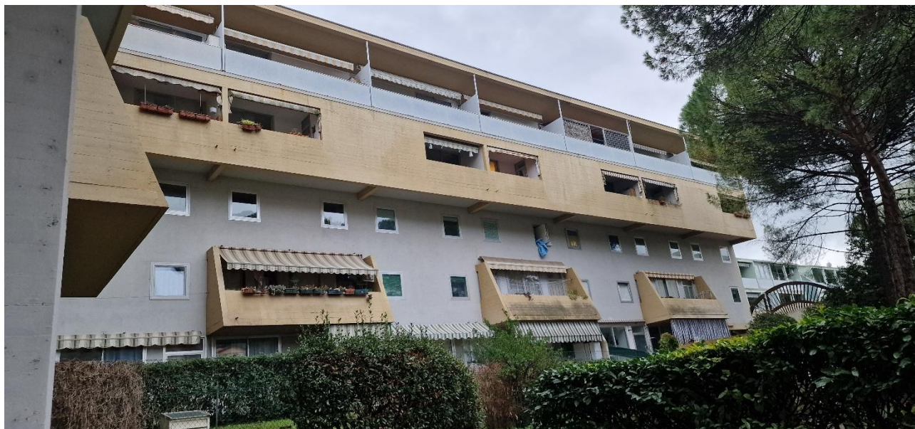
Foto n. 1 – Facciata dell'edificio prospiciente l'area cortilizia – vista n.1
