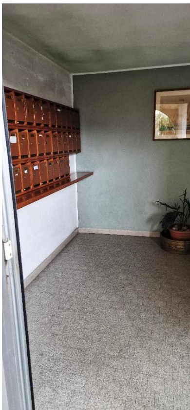
Foto n.11 – Atrio d'ingresso dell'edificio al piano terra
