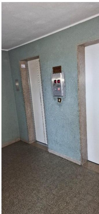
Foto n.12 – Atrio d'ingresso dell'edificio al piano terra - vista verso ascensori
