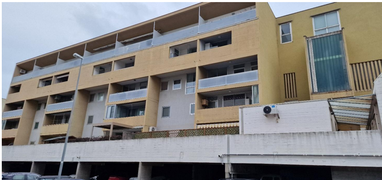
Foto n. 3 – Facciata dell'edificio prospettante verso il viale XXV Aprile
