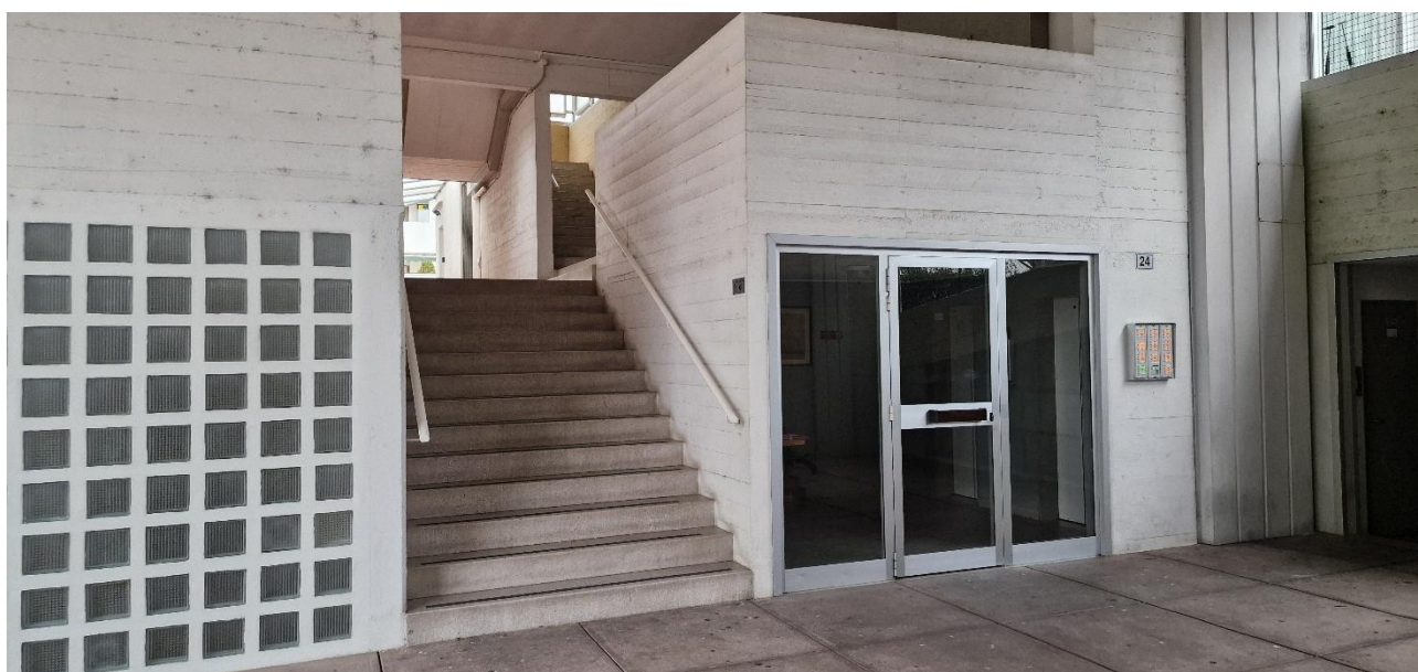
Foto n.6 — Area esterna d’ingresso dell’edificio civ. n. 24 – vista n.2
