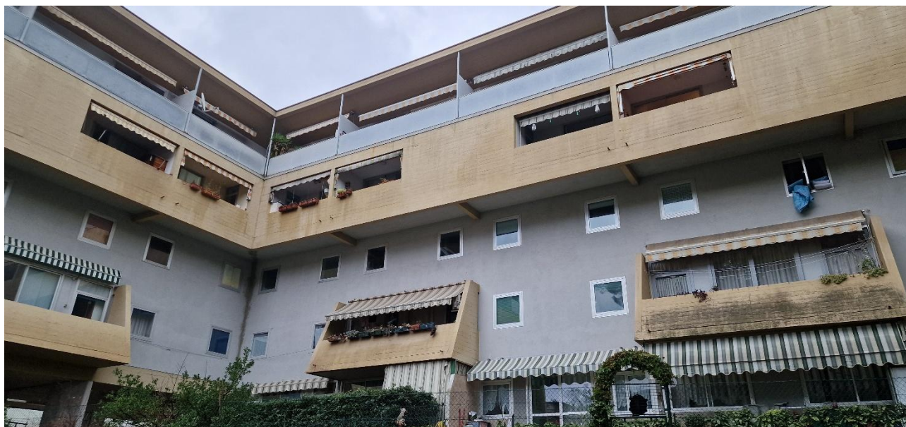
Foto n. 2 – Facciata dell'edificio prospiciente l'area cortilizia – vista n.2
