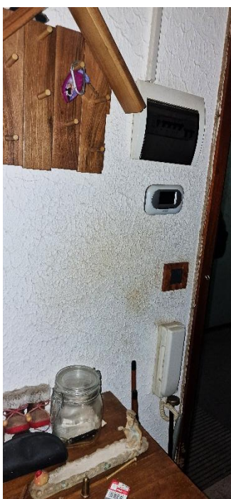
Foto n.44 – Atrio d'ingresso – vista di dettaglio n.7
