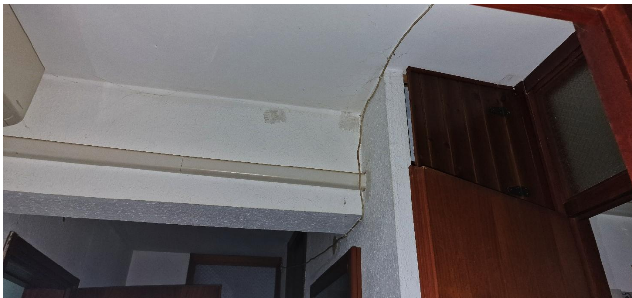
Foto n.40 – Atrio d'ingresso – vista di dettaglio n.3
