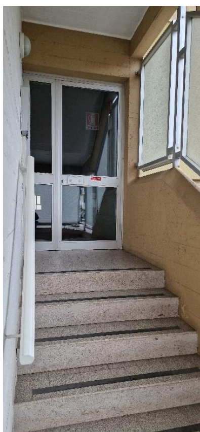
Foto n.10 – Vista verso il portone d'ingresso posto al secondo piano
