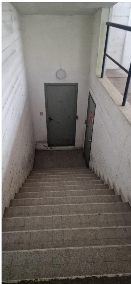
Foto n.49 – Vista scale di accesso al piano scantinato adibito a cantine
