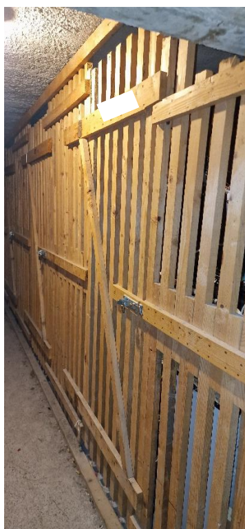
Foto n.50 – Cantina- vista di dettaglio n.1
