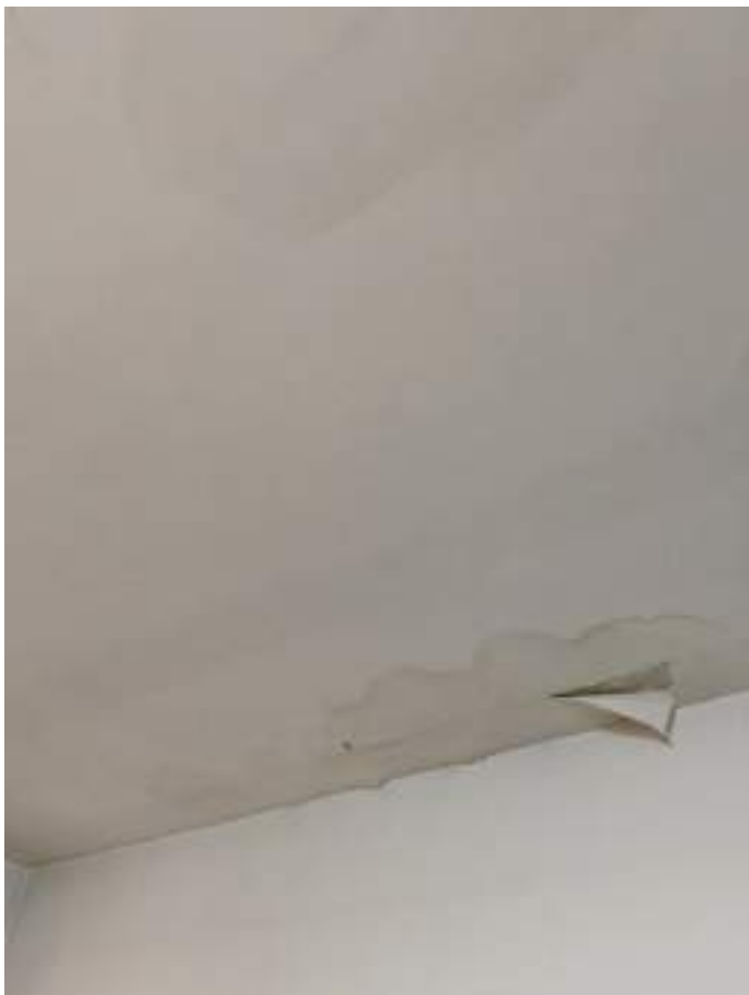
Figura 8: interno unità immobiliare (particolare infiltrazione proveniente dal lastrico solare)
