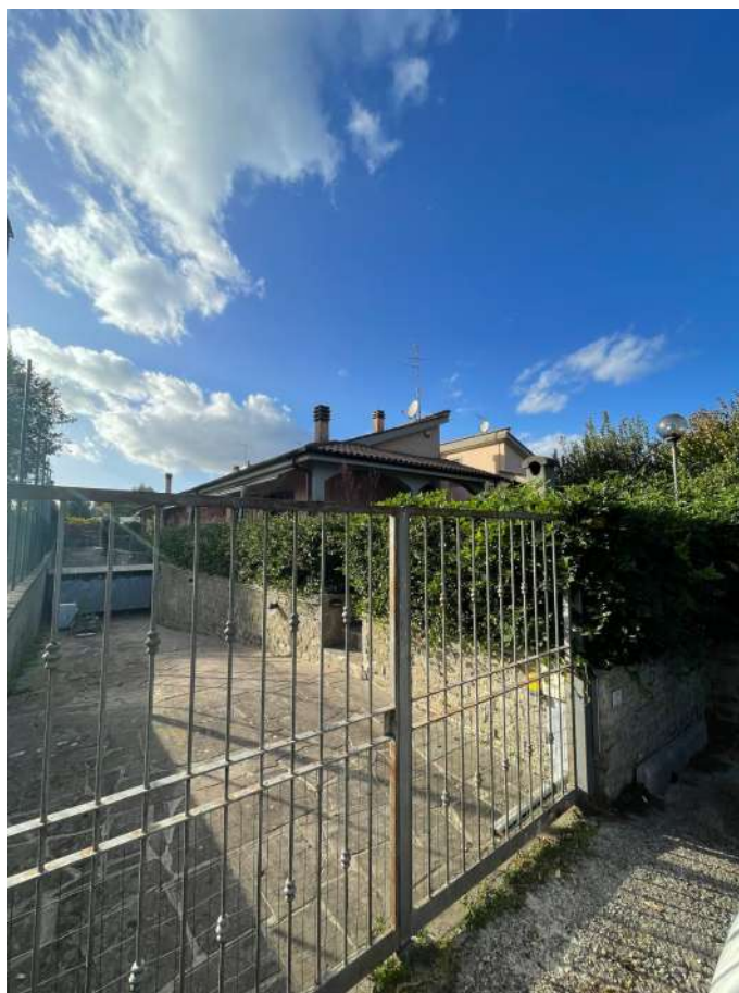
Foto 1 – Vista degli ingressi da Via delle Robinie
