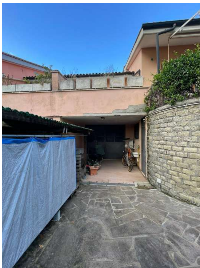
Foto 12 – Vista della rampa esterna di accesso al garage
