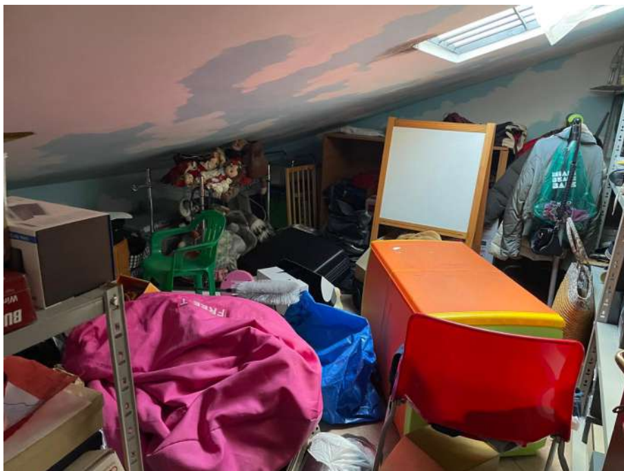
Foto 15 – Vista del secondo locale sottotetto
