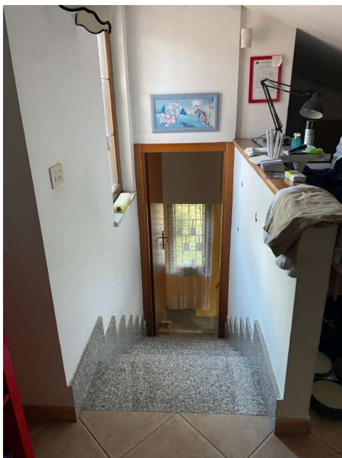
Foto 8 – Vista della scala interna
