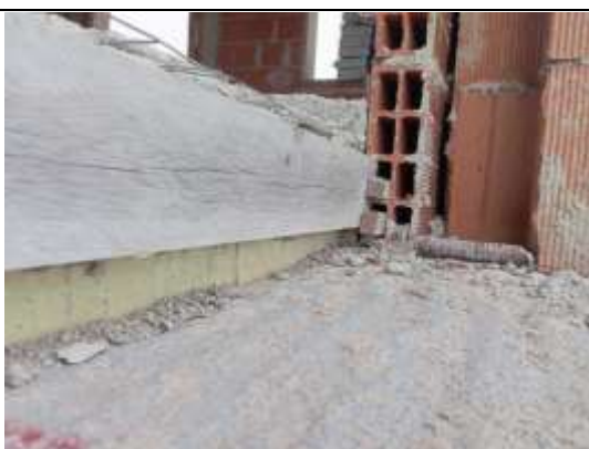
Piano primo particolare pavimento
