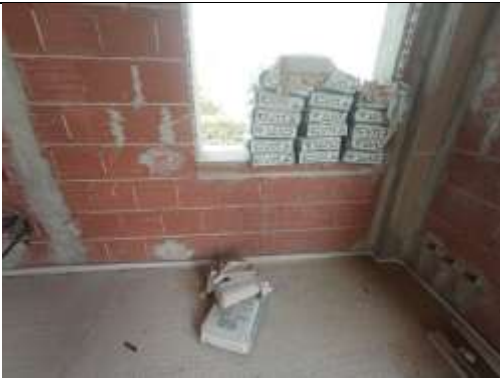
Foto 29: materiale di cantiere
