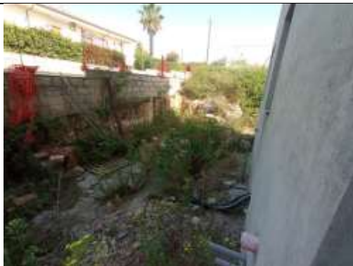
Foto 40: veduta ingresso seminterrato
