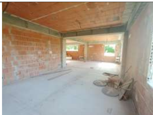
Piano seminterrato interno S-W
