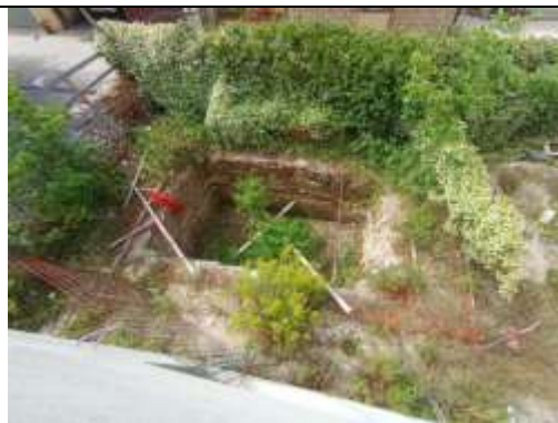
Foto 34: fossato prospetto sud
