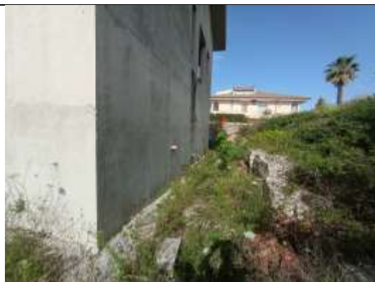
Scannafosso lato Nord
