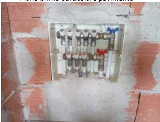
Piano primo particolare impianto acqua
