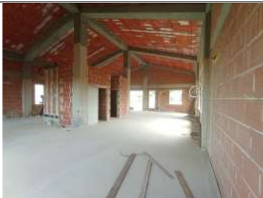
Piano primo interno lato S-E
