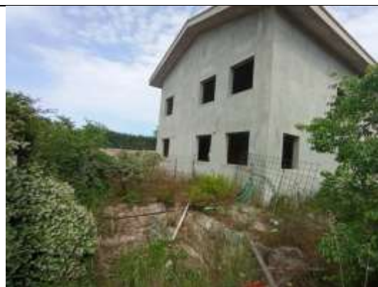
Scannafosso con scavo serbatoio lato Sud
