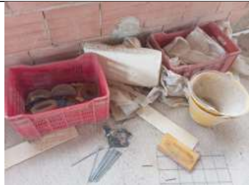
Foto 30: materiale di cantiere
