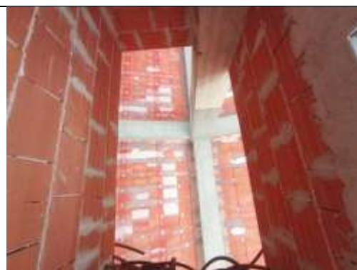
Foto 24: cielo locale tecnico
