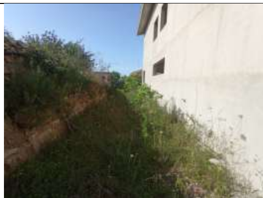
Scannafosso lato Est
