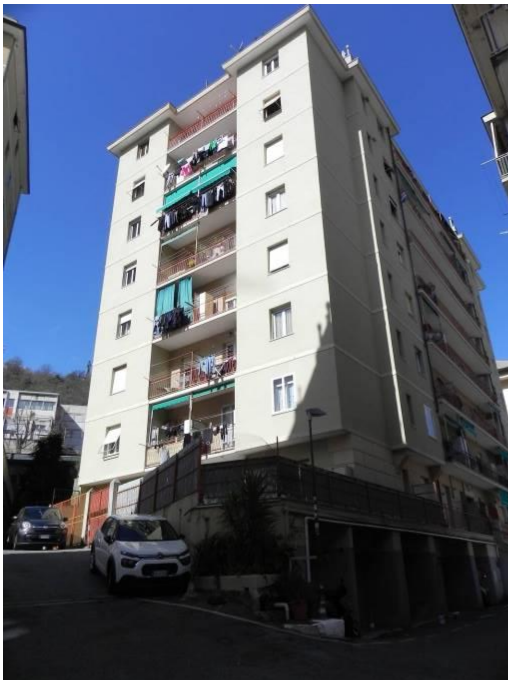
Foto 9 - Vista del condominio di Via Mantova 35 da valle
