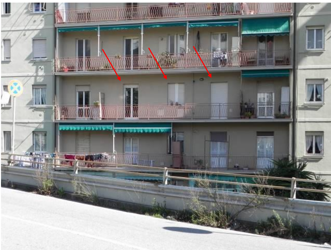
Foto 10 e 11 - Vista del condominio di condominio di Via Mantova 35 fotografato da Via Salvador Allende In evidenza la linea delle finestre (tre luci) al 5° piano dell'appartamento oggetto di procedura
