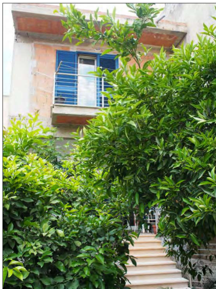
FOTO n. 2: vista del retroprospetto dall'orto/giardino sul retro
