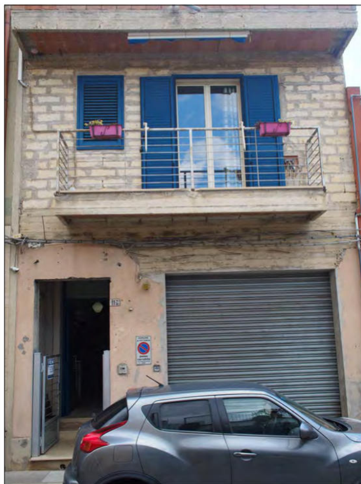
FOTO n. 1: vista del prospetto su Via Fratelli Bandiera
