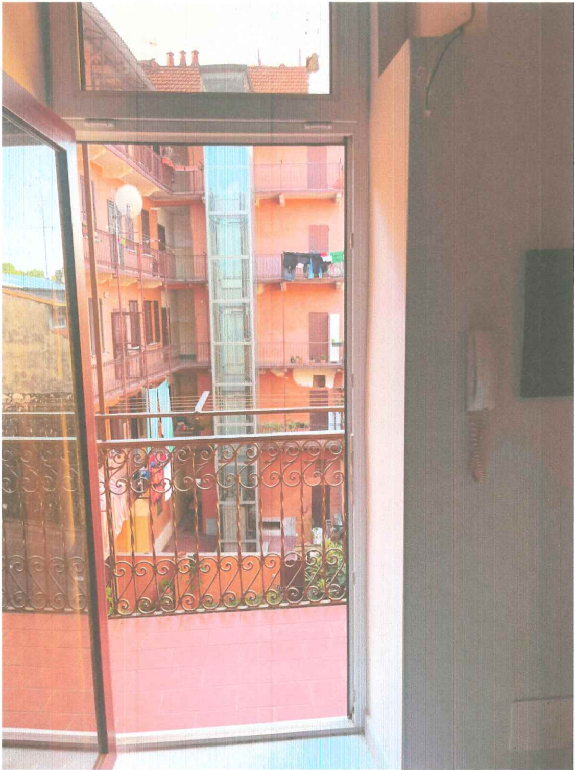
Ingresso dal ballatoio
