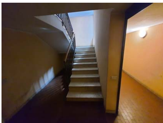
RILIEVO AUTORIMESSA – Foto 72 -76. Dettaglio della centrale termica condominiale. Riprese del percorso condominiale di accesso al piano autorimesse e cantine.
