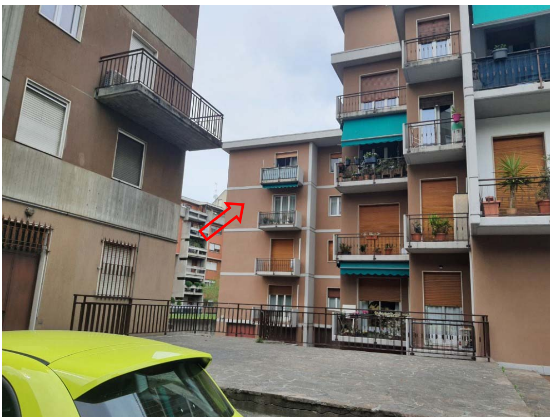
RILIEVO ESTERNO – Foto 4 e 5.
