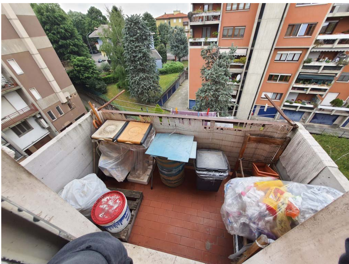
RILIEVO INTERNO – Foto 19 e 20. Riprese dei balconi dei locali Soggiorno-Pranzo e Cucina.
