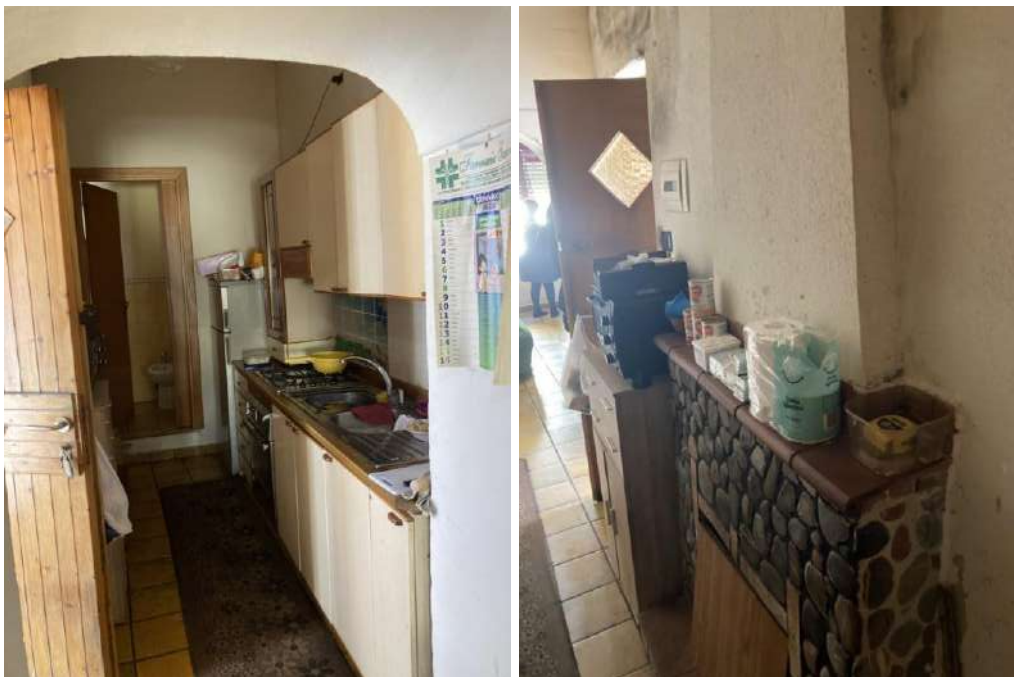
Fig. 15-16-17: viste della cucina al piano primo . Si noti la presenza di vistose macchie di umidità ed intonaco degradato, soprattutto in prossimità del soffitto.
