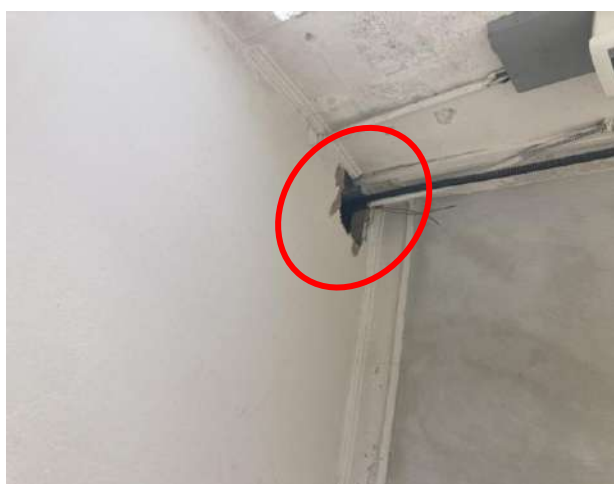
Fig. 21-22-23: ulteriori viste del deposito al piano terra, con accesso indipendente da via F. Mancusi civ. 6. L'ambiente risulta solo in parte pavimentato. Sono stati riscontrati un foro sul soffitto, parzialmente occluso, ed imperfezioni nei collegamenti impiantistici, con finiture incomplete.
