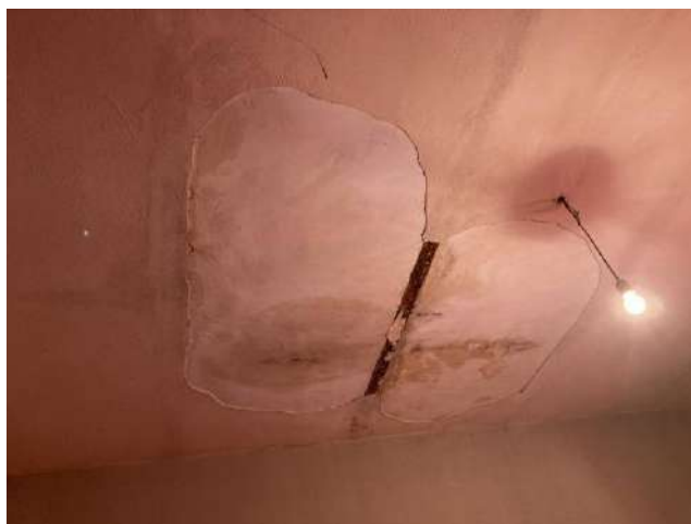
Fig. 12-13-14: viste della camera da letto al piano primo , con affaccio esclusivamente finestrato e presenza di macchie di umidità in prossimità del soffitto, e presenza di infiltrazioni d'acqua.
