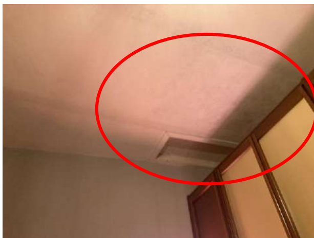
Fig. 12-13-14: viste della camera da letto al piano primo , con affaccio esclusivamente finestrato e presenza di macchie di umidità in prossimità del soffitto, e presenza di infiltrazioni d'acqua.
