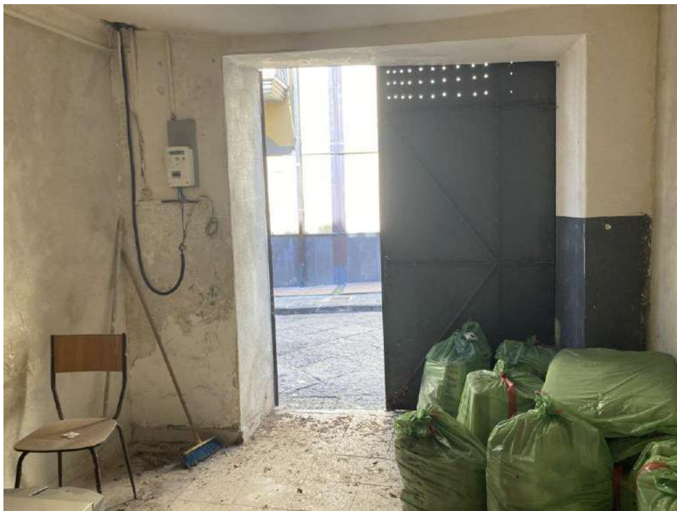
Fig. 20: viste del deposito al piano terra , con accesso indipendente da via F. Mancusi civ. 6. L'ambiente è dotato di porta metallica ad apertura manuale, nonché di impianto elettrico. Sono stati rinvenuti modesti quantitativi di rifiuti.
