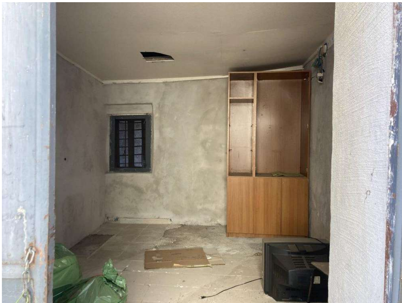
Fig. 21-22-23: ulteriori viste del deposito al piano terra, con accesso indipendente da via F. Mancusi civ. 6. L'ambiente risulta solo in parte pavimentato. Sono stati riscontrati un foro sul soffitto, parzialmente occluso, ed imperfezioni nei collegamenti impiantistici, con finiture incomplete.
