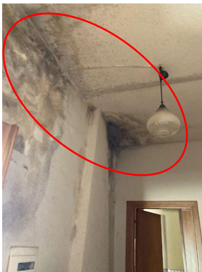
Fig. 15-16-17: viste della cucina al piano primo . Si noti la presenza di vistose macchie di umidità ed intonaco degradato, soprattutto in prossimità del soffitto.
