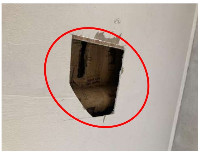
Fig. 21-22-23: ulteriori viste del deposito al piano terra, con accesso indipendente da via F. Mancusi civ. 6. L'ambiente risulta solo in parte pavimentato. Sono stati riscontrati un foro sul soffitto, parzialmente occluso, ed imperfezioni nei collegamenti impiantistici, con finiture incomplete.
