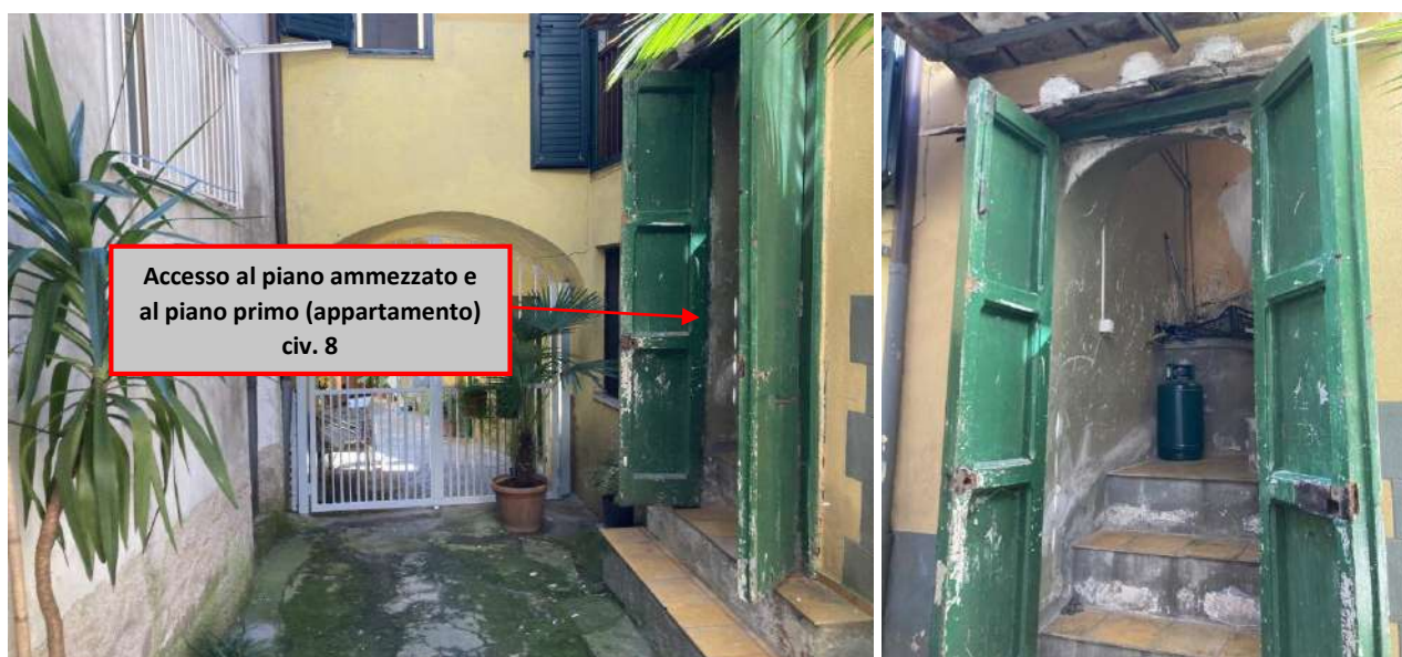
Fig. 5-6: viste del portone di ingresso al Lotto Unico, subb. 2-5, sito al piano ammezzato e al piano primo, a mezzo vano scale privo di ascensore .
