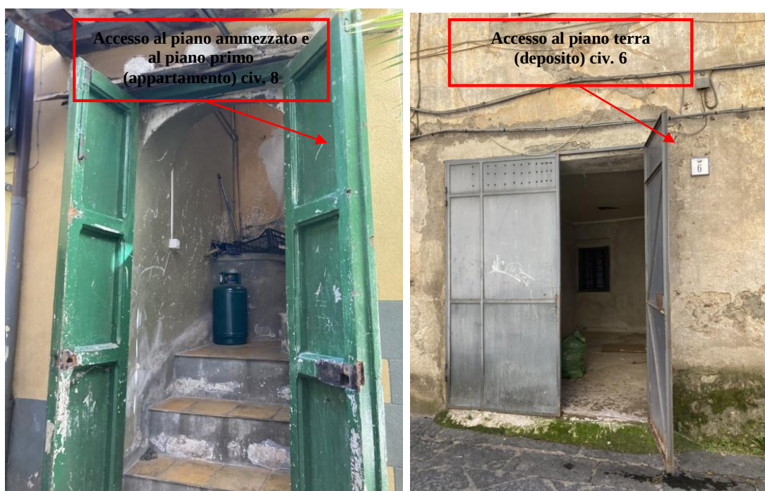
Fig. 2-3: viste degli accessi rispettivamente all'appartamento piano primo e ammezzato, da corte comune ad altri fabbricati con accesso da via Mancusi al civ. 6 e ingresso al deposito a piano terra con ingresso direttamente da Via Mancusi al civ. 8.
