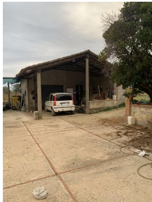
Tettoia e locale di sgombero
