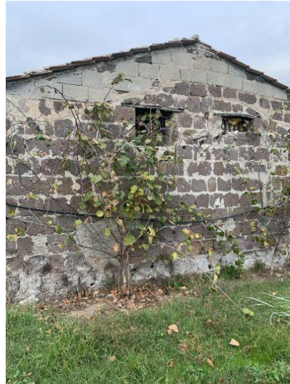
Retro tettoia e locale di sgombero
