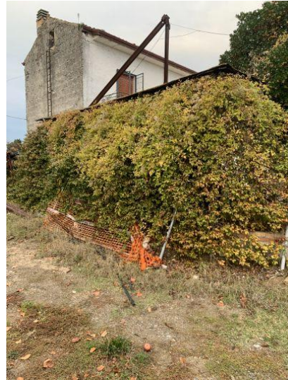
Retro tettoia aperta
