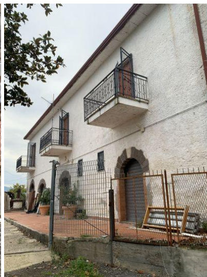
ingresso da strada
