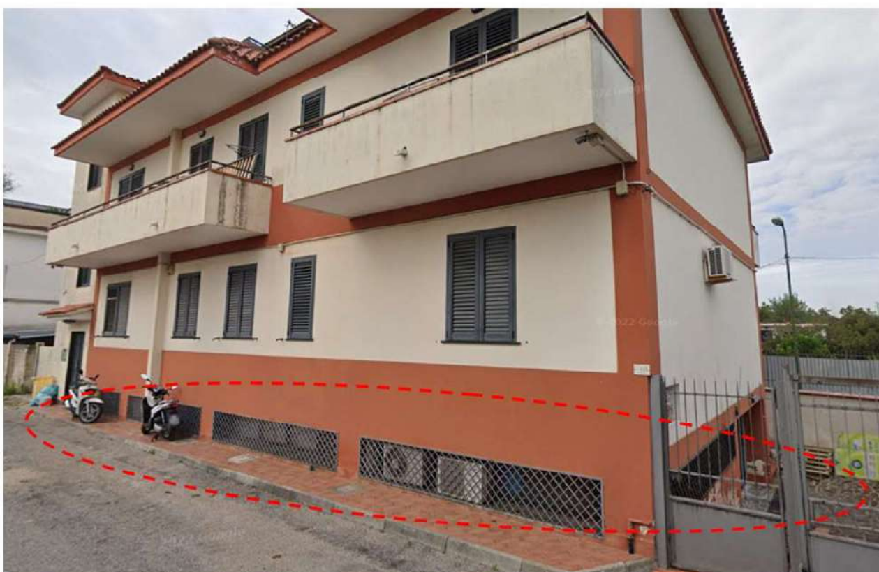
FOTO 06: VISTA DEL FABBRICATO
