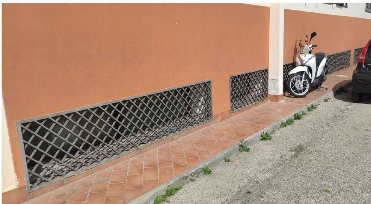
FOTO 10: FINESTRE LOCALI AL PIANO SEMINTERRATO
