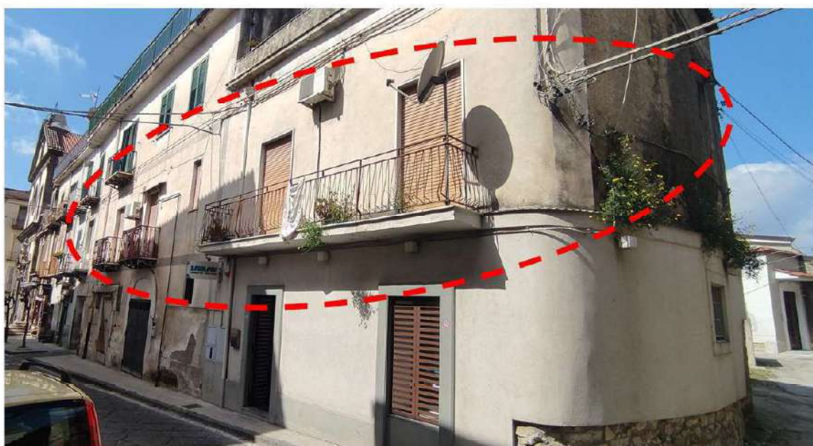
FOTO 06: VISTA DEL FABBRICATO
