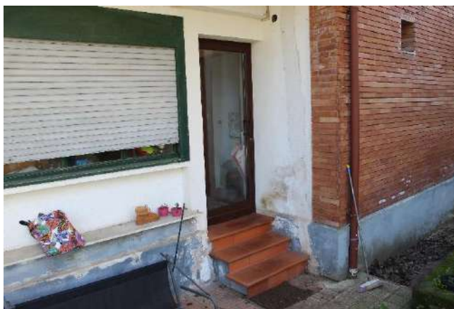
Vista parete esterna-basamento
