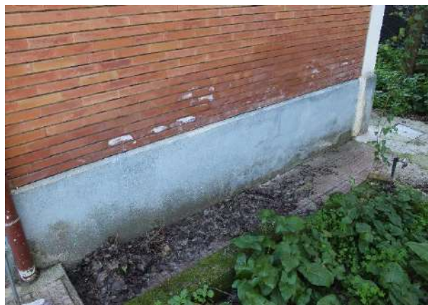
Vista parete esterna-basamento
