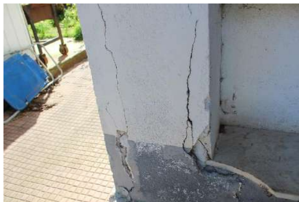
Vista parete esterna-pilastro d'angolo
