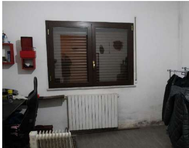
Vista parete interna vano L2
