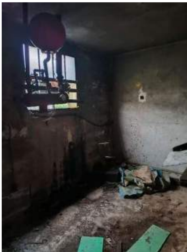
FOTO 6: vista interna del capannone artigianale
