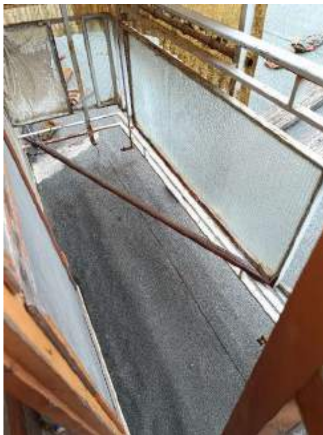
FOTO 18: vista dal tinello del balcone non agibile sul lato est dell'unità immobiliare
