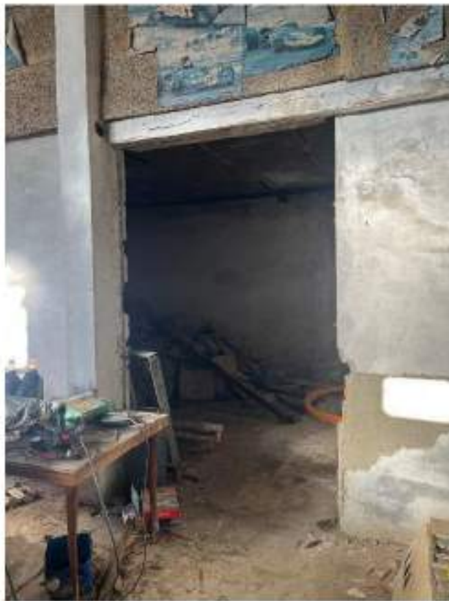
FOTO 10: vista interna del capannone artigianale
