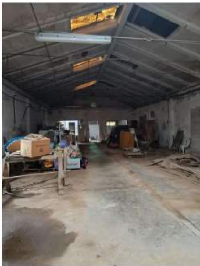
FOTO 2: vista interna del capannone artigianale
