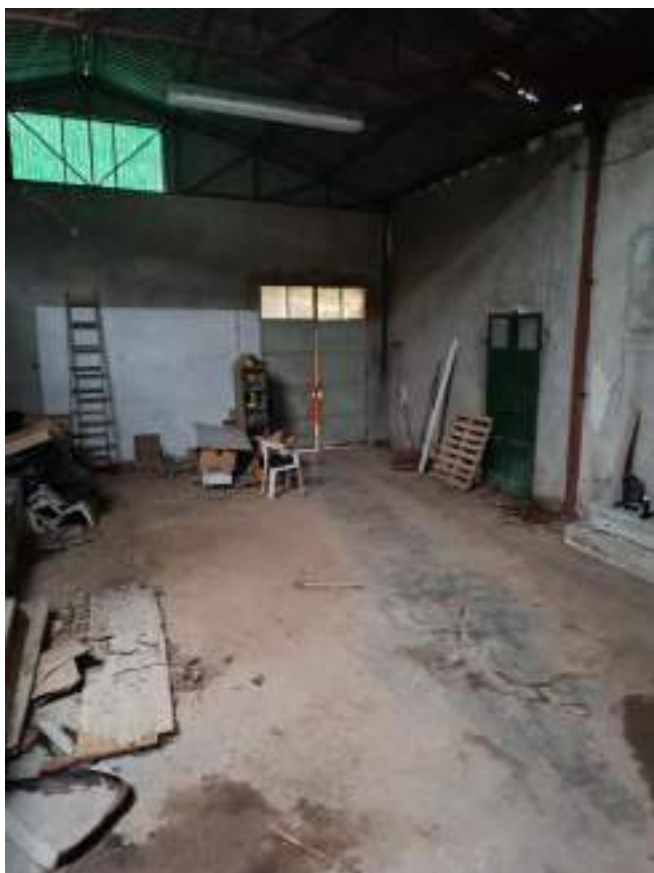
FOTO 7: vista interna del capannone artigianale
