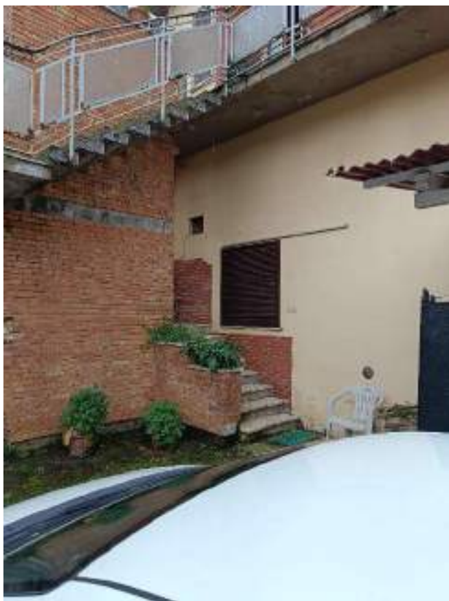
FOTO 5: scale esterne di accesso all'abitazione
