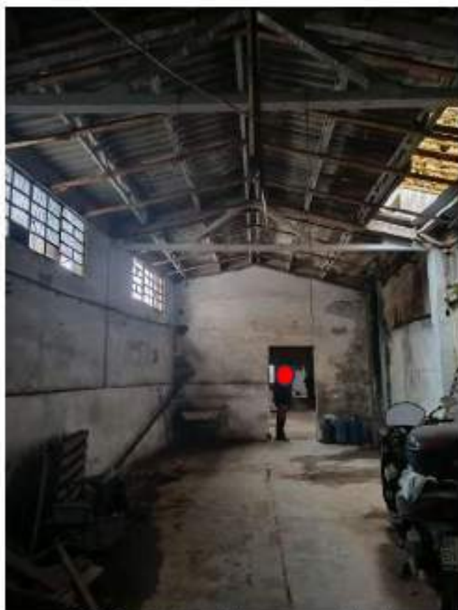
FOTO 3: vista interna del capannone artigianale
