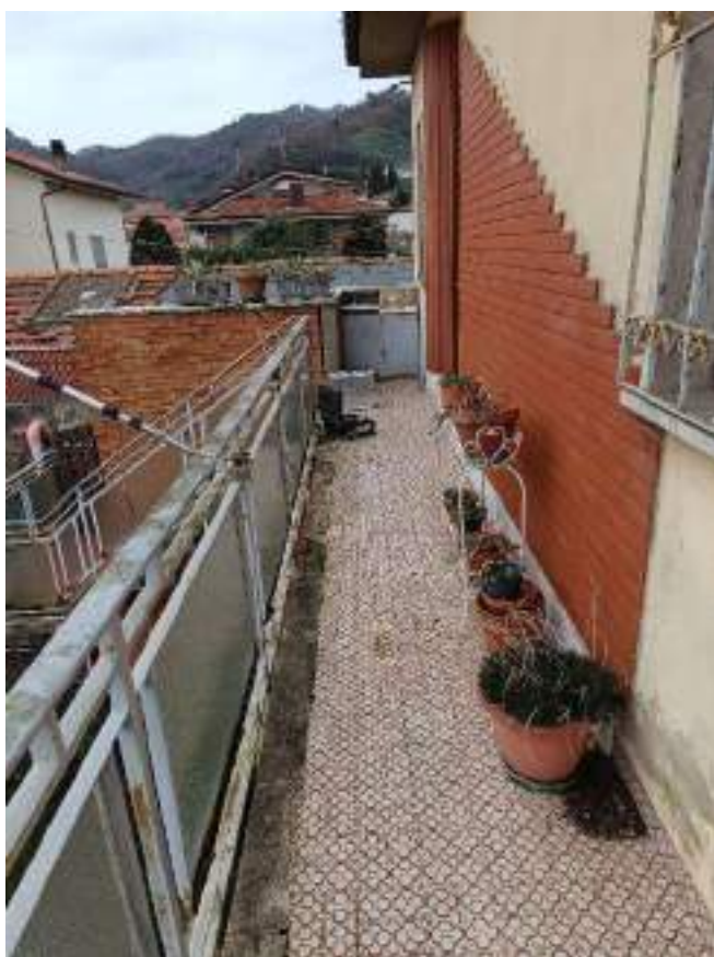
FOTO 19: vista del balcone sul lato nord dell'unità immobiliare
