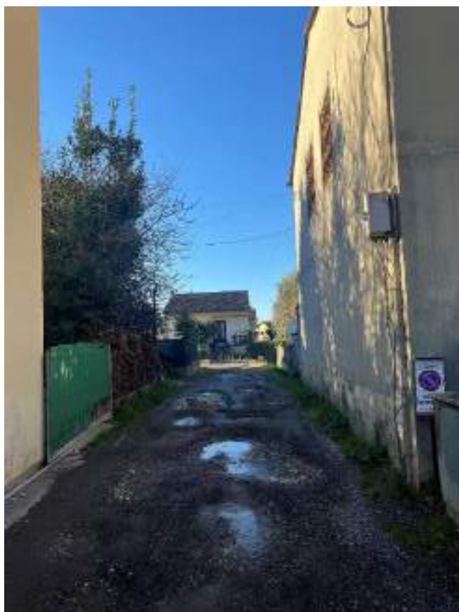
FOTO 1: vista del viale di accesso (mappale 307) al lotto da via Sarzanese
