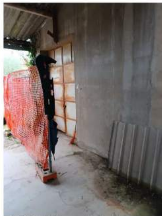
FOTO 12: vista dell'ingresso agli immobili dal passo a comune (part. 1438, sub 4)
