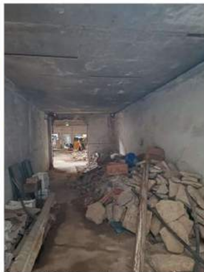
FOTO 4: vista interna del capannone artigianale
