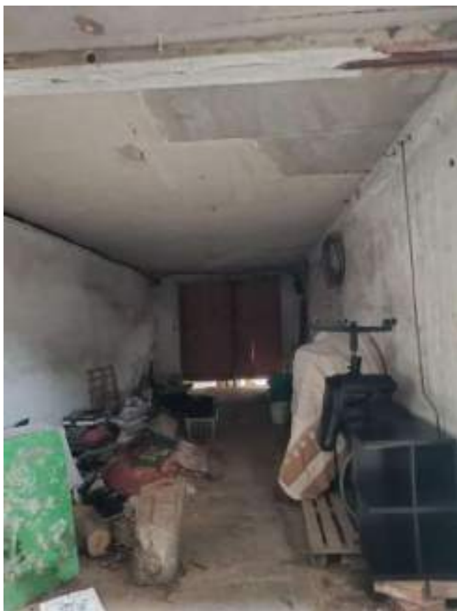
FOTO 5: vista interna del capannone artigianale
