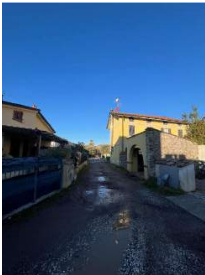
FOTO 2: vista del viale di accesso al lotto (mappale 1084) da mappale 1486
