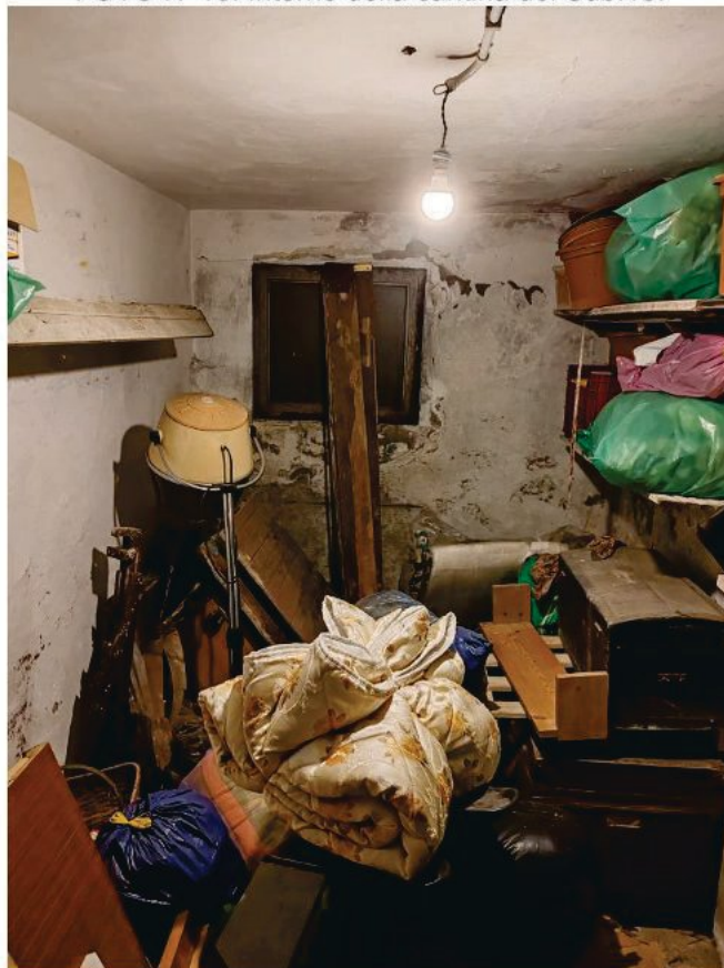
FOTO N°16: Interno della cantina del Sub.18.
