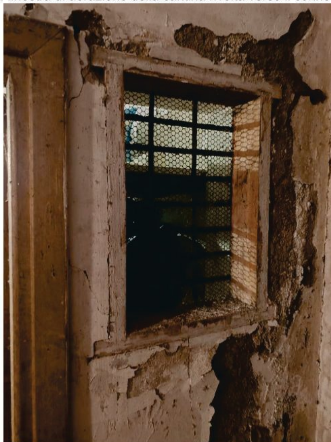
FOTO N°15: finestra di aerazione della cantina rivolta verso il connettivo comune.
