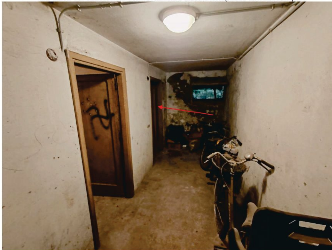
FOTO N°14: Corridoio comune di accesso alla cantina (Piano Seminterrato).
