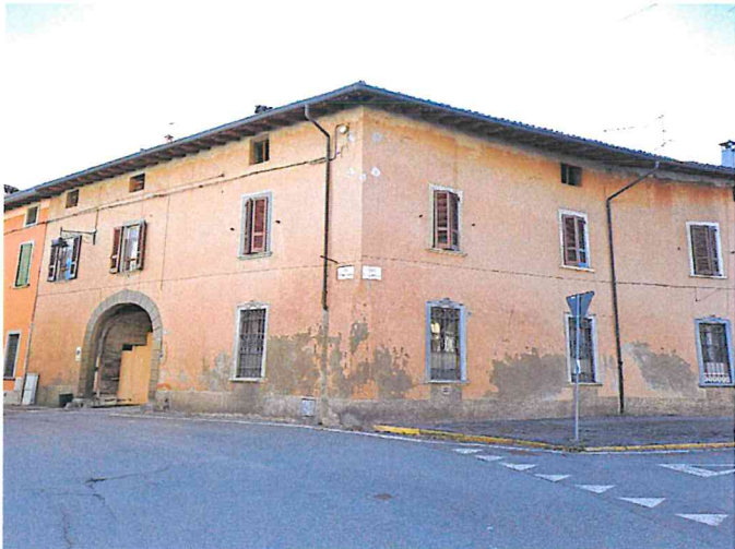
Foto 01 - Vista d'insieme edificio.jpg
