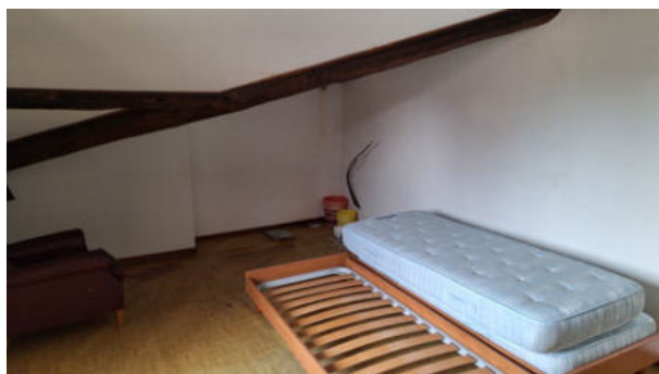
VISTA SOFFITTA P. 2°
