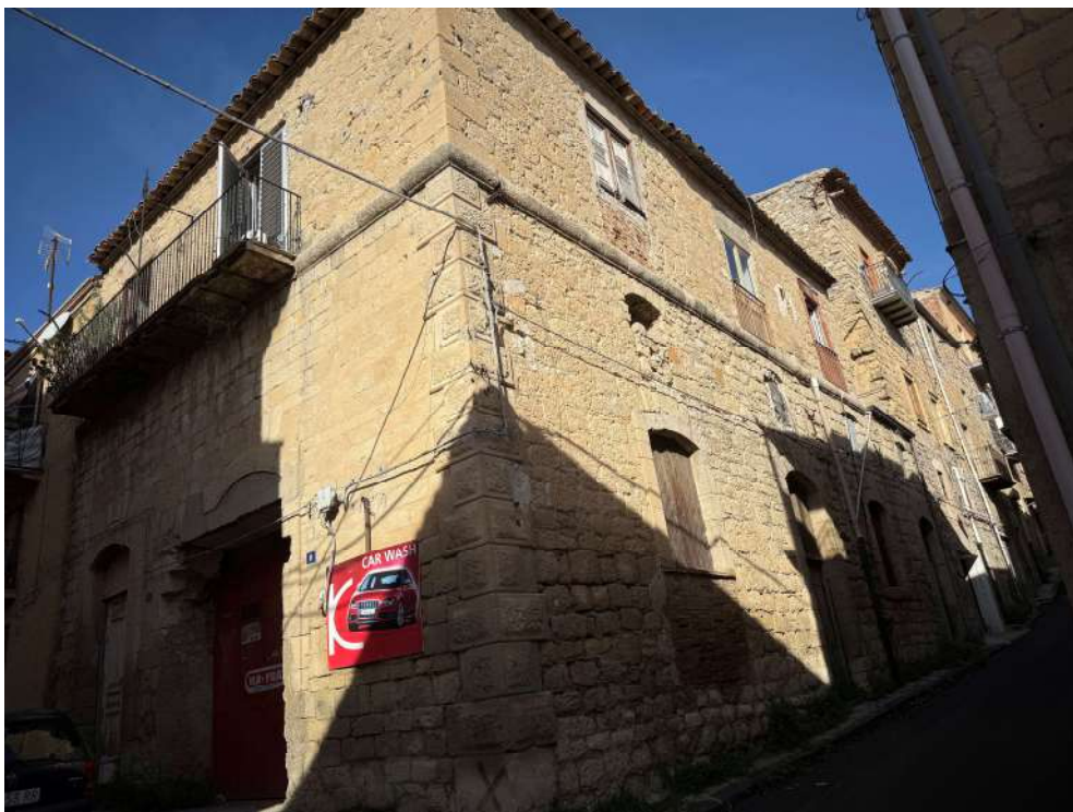
FOTO 24 --- PROSPETTO SU VIA BUTERA – VIA TORREGROSSA
