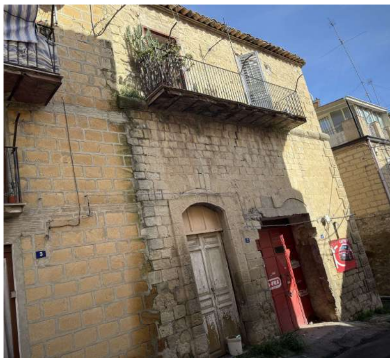
FOTO 23 --- PROSPETTO SU VIA BUTERA
