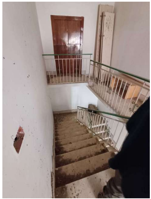
FOTO 8 --- VANO 2 - SCALA P. 1
