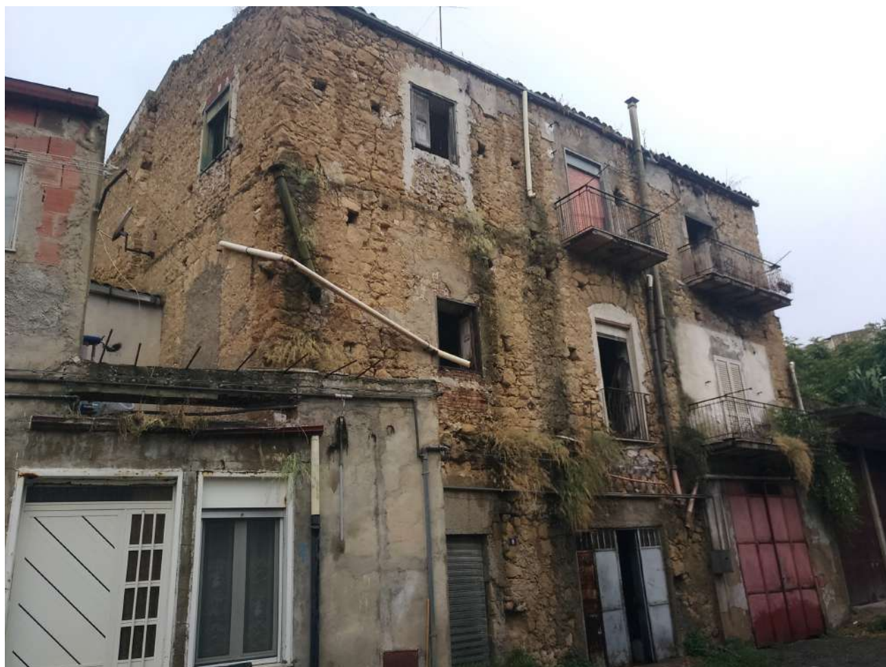
FOTO 2 --- PROSPETTO SU VIA STENDITOI –
