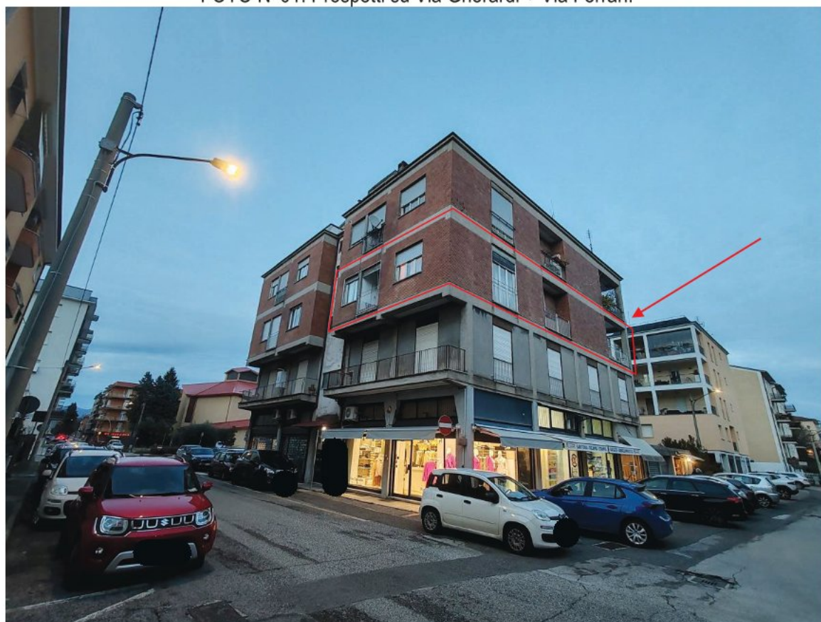
FOTO N°01: Prospetti su Via Gherardi + Via Ferrari.
