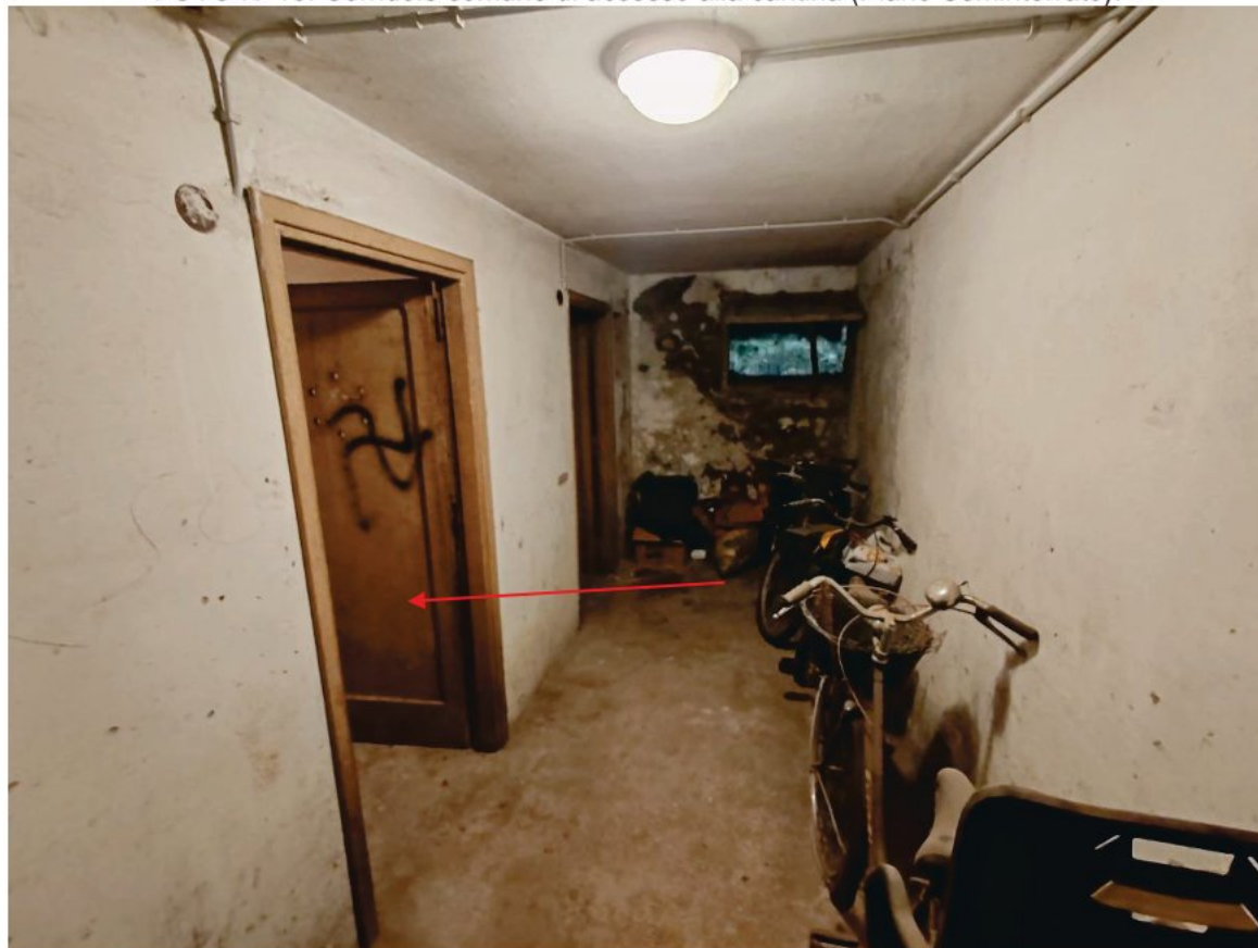
FOTO N°18: Corridoio comune di accesso alla cantina (Piano Seminterrato).
