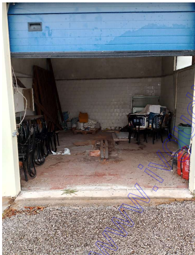
FOTO 5: INTERNO DEPOSITO LATO EST
