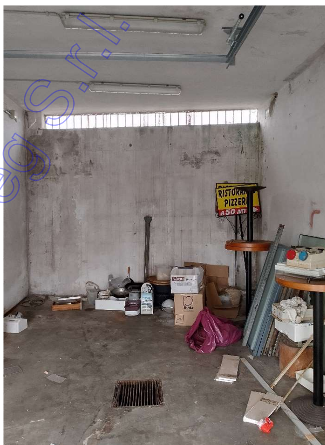
FOTO 6: INTERNO DEPOSITO LATO OVEST
