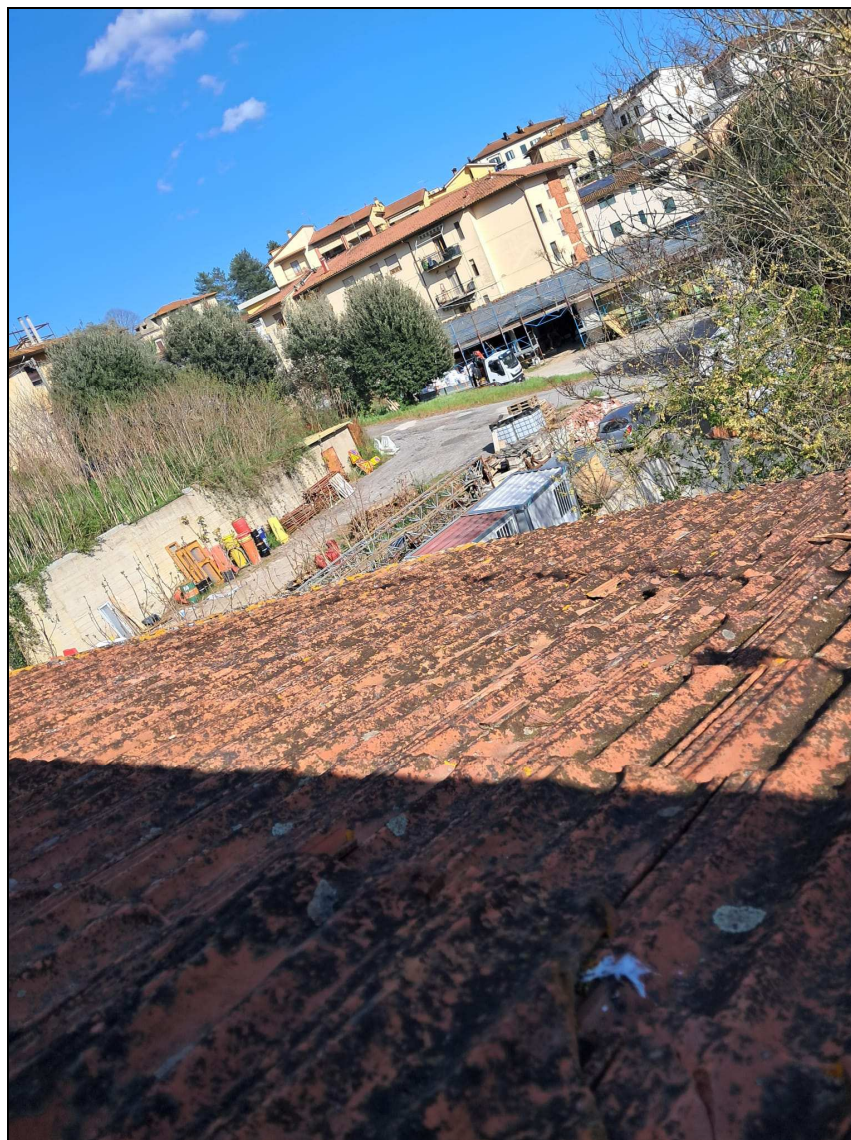
Foto 2 – foto manto di copertura
