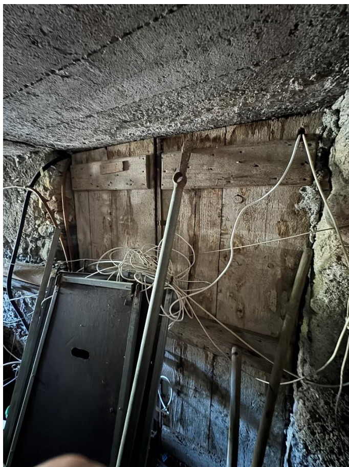
Lotto 1 – ex passaggio in int 1 foto 15
