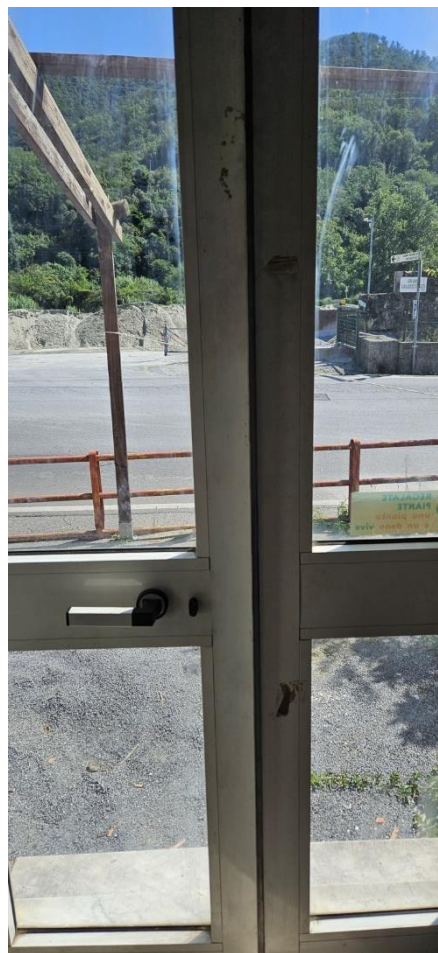
Lotto 2 – attuale ingresso fronte strada foto 21
