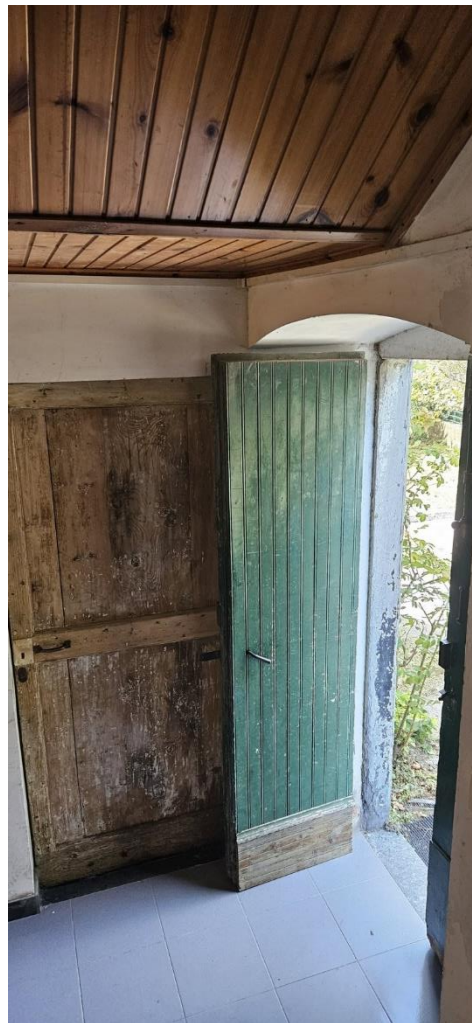
Portone di ingresso oggi civ. 102 A foto 17
