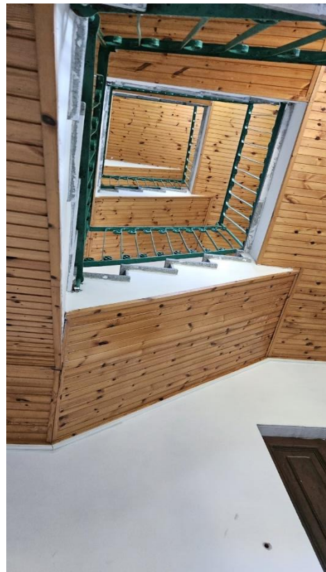
Lotti 1-2 - vano scala foto 19
