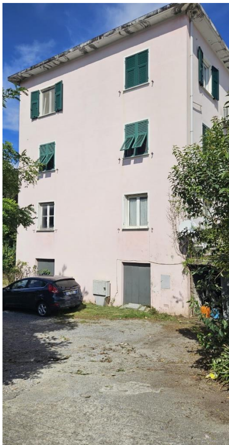
Prospetto sud e accesso carrabile n. 1 foto F
