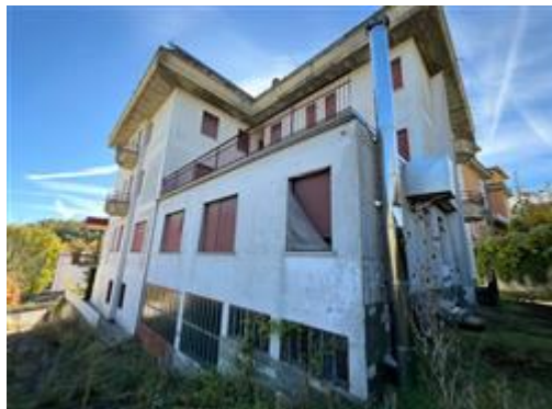
Foto - Prospetto est
