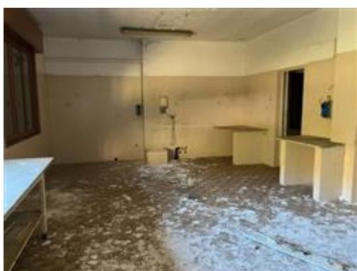
Foto - Piano terra
