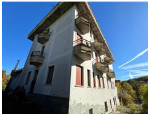
Foto - Prospetto nord-ovest
