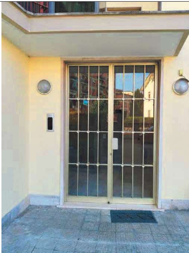
N°15 ESTERNO - vista sul portone di ingresso principale alla palazzina (condominio [REDACTED]); ove sono localizzati l'appartamento, la cantina e il box auto oggetto di E.I. (LOTTO UNICO)
