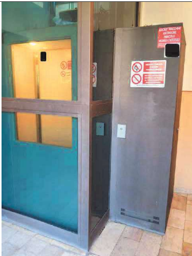
N°17 INTERNO – parti comuni – PIANO TERRA - vista del vano ascensore della palazzina (condominio [redacted]) - ove sono localizzati l'appartamento, la cantina e il box auto oggetto di E.I. (LOTTO UNICO)
