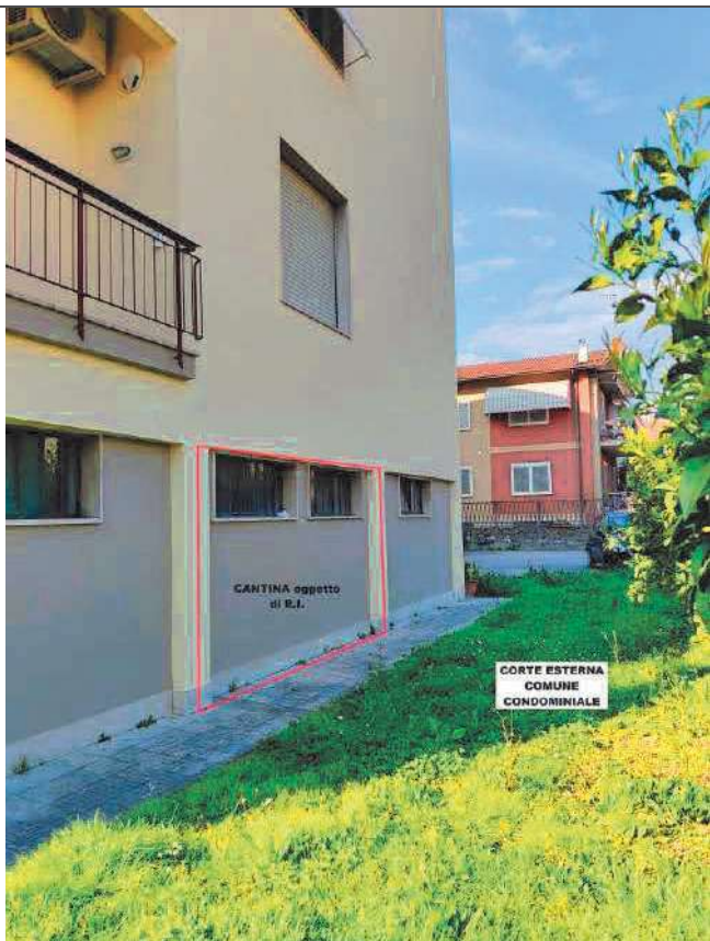
N°42 ESTERNO CANTINA - piano terreno – vista sulle finestre del locale CANTINA oggetto di E.I., prospettanti sulla corte comune condominiale lato sud est
