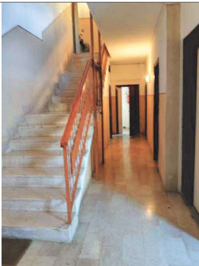
N°16 INTERNO - parti comuni – PIANO TERRA - vista dell'atrio comune dell'ingresso principale alla palazzina (condominio [REDACTED]) - ove sono localizzati l'appartamento, la cantina e il box auto oggetto di E.I. (LOTTO UNICO); a sinistra il corpo scale comune che conduce ai piani superiori
