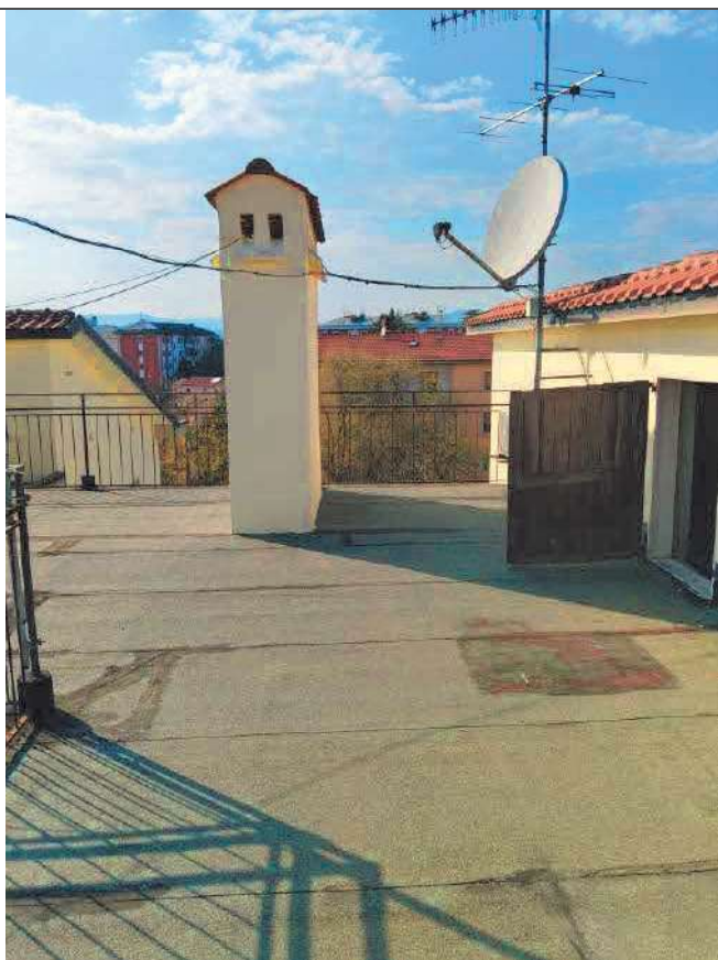
N°50 ESTERNO COPERTURA - LASTRICO SOLARE CONDOMINIALE - altra vista lastrico solare - porzione della copertura piana della palazzina (condominio [REDACTED]) a destra una delle piccole porte di accesso ai sottotetti comuni non abitabili
