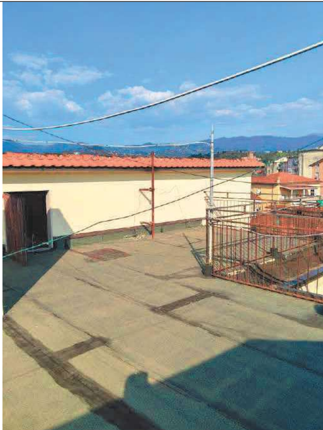
N°49 ESTERNO COPERTURA - LASTRICO SOLARE CONDOMINIALE - vista lastrico solare - porzione della copertura piana della palazzina (condominio [REDACTED])
