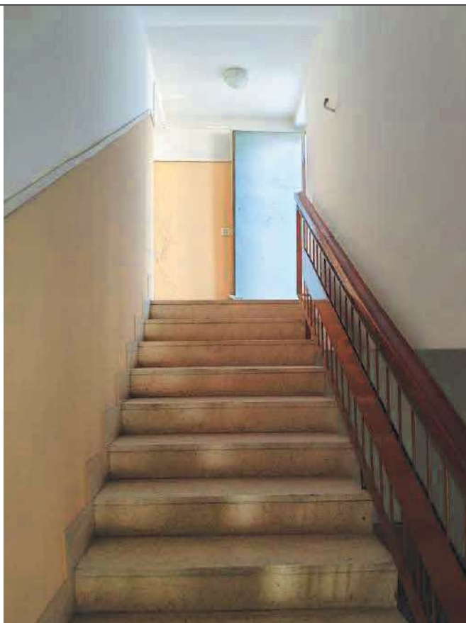
N°48 INTERNO PARTI COMUNI - VANO SCALE CONDOMINIALE - vista del vano scale comune che conduce al lastrico solare in copertura
