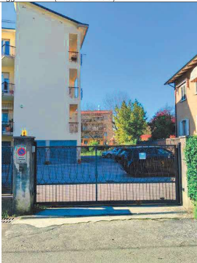
N°8 ESTERNO - altra foto da via IV Novembre della palazzina (condominio ██████████); vista dal cancello carrabile scorrevole che immette nella corte comune condominiale della palazzina (Condominio ██████████) ove sono localizzati l'appartamento, la cantina e il box auto oggetto di E.I. (LOTTO UNICO)
