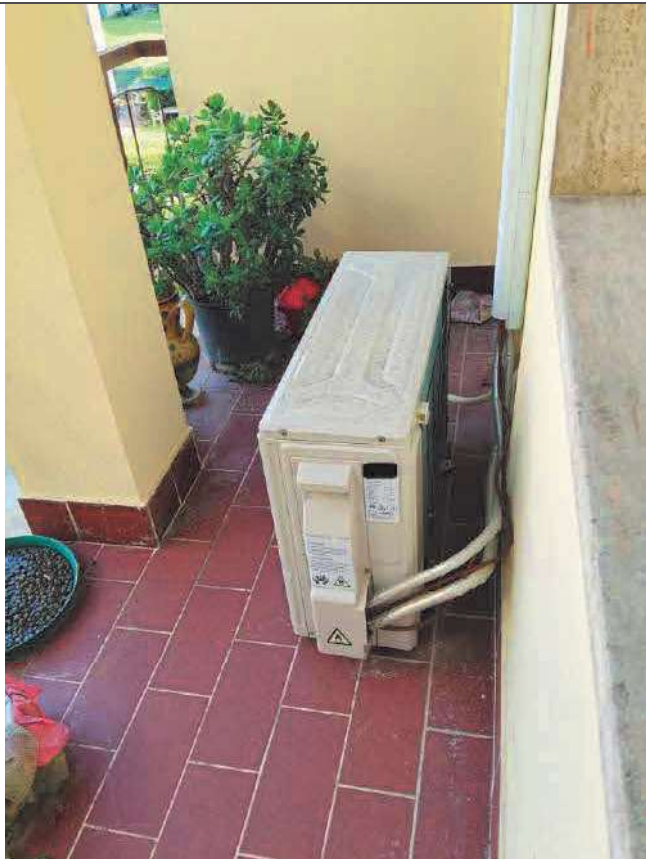
N°39 ESTERNO APPARTAMENTO - piano secondo - vista del terrazzo (esposto a nord est) accessibile dal Bagno 1
