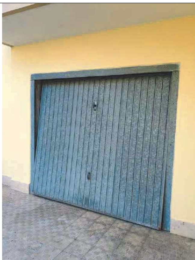
N°46 ESTERNO BOX AUTO – piano terreno – vista della porta basculante che consente l'accesso carrabile al BOX AUTO oggetto di E.I.
