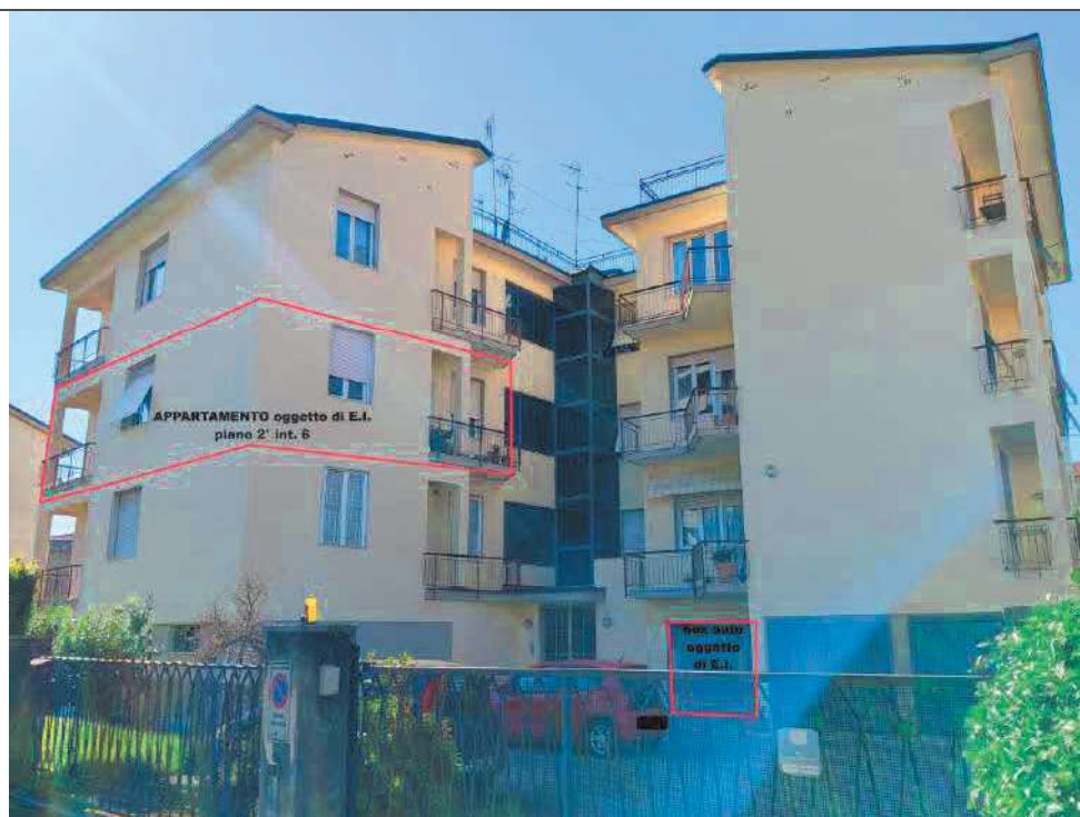
N°6 ESTERNO – altra foto da via IV Novembre della palazzina (condominio [REDACTED]) con indicazione nel poligono rosso della localizzazione dell'appartamento (2° piano) e dell'accesso box auto (piano terreno) oggetto di E.I. (LOTTO UNICO)
