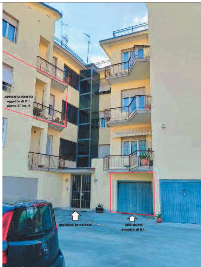
N°45 ESTERNO BOX AUTO – piano terreno - vista sull'accesso al BOX AUTO (a mezzo di porta basculante), accessibile carrabilmente dalla corte comune condominiale; in altro, a sinistra, con perimetro rosso viene indicato l'appartamento (2° piano) oggetto di E.I.
